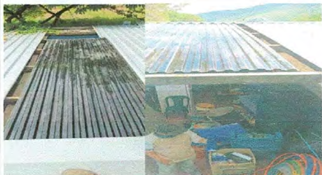
FOTO 1: Sustrucción de lamina por lamina troquelada calibre 26 y tragaluz
