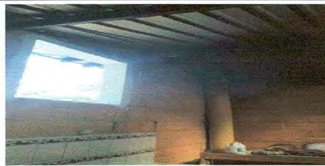
FOTO 6: Sustrucción de estructura de metal de ventana 0.90*0.90mts con vidrios
