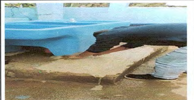
FOTO 12: Sustitución de pila plástica con dos lavaderos
