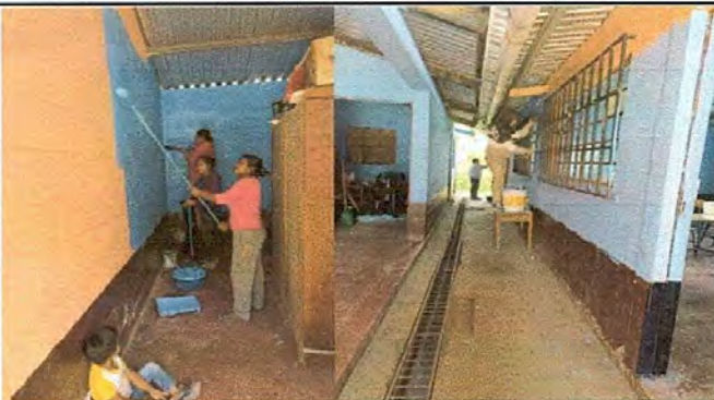
FOTO 9: Pintura de muros exteriores e interiores
