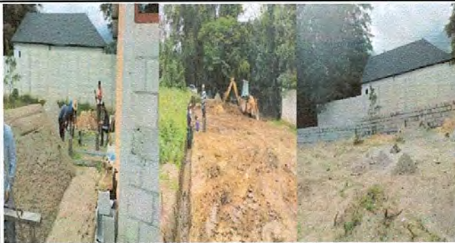
FOTO 11: Sustitución de muro perimetral madera y malla por clock con tubo hg y malla galvanizada, solera y columnas
