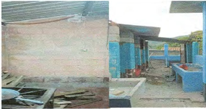
FOTO 13: Sellado de grietas y fisuras de muros (sabieta) de cocina y baños
