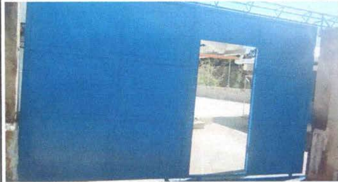
Foto 1: Sustitución de portón de metal 2.50 alto x 3 mts ancho
