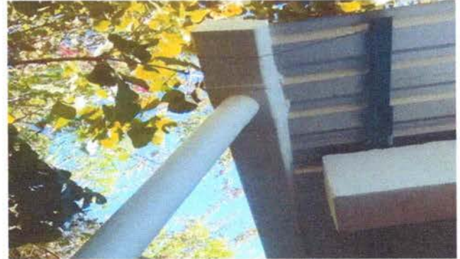
Foto 2: Sustitución de canal de pvc
