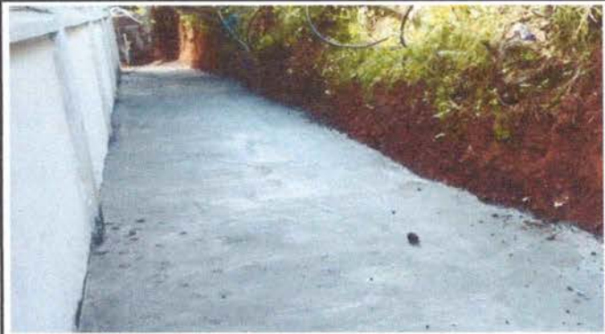
Foto 4: Sustitución de banquetta de concreto
