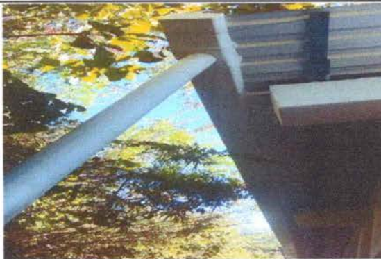
Foto 3: Sustitución de bajada de agua pluvial, tubo pvc 3"
