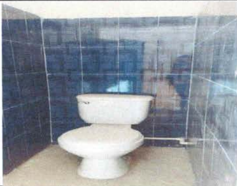
Foto 5: Sustitución de azulejo en baños
