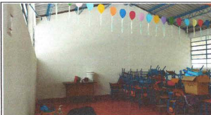
Foto 9: Repello en muro
