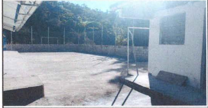
Foto 6: Sustitución de muro perimetral de block con tubo hg y malla galvanizada, soleras intermedias
