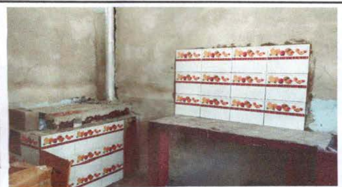
Foto 5: Sustitución de azulejo en baños
