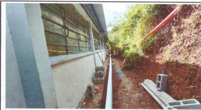
Foto 4: Sustitución de banqueta de concreto
