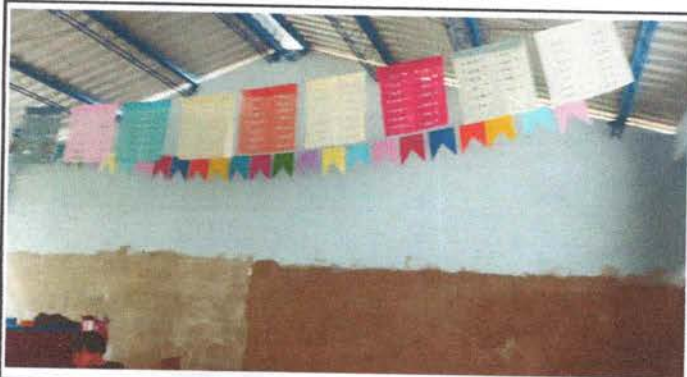
Foto 9: Repello en muro
