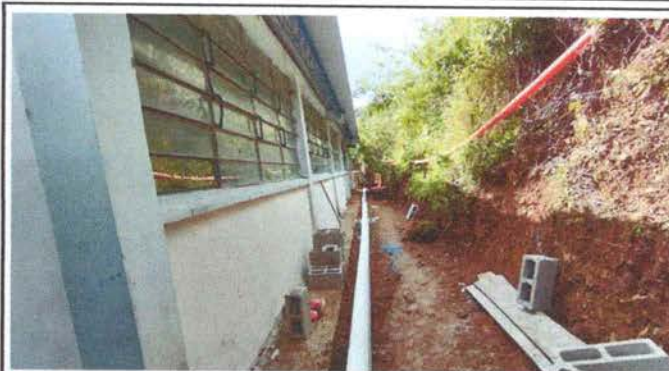
Foto 2: Sustitución de canal de pvc
