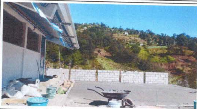
Foto 7: Sustitución de adoquín por torta de cemento en patio
