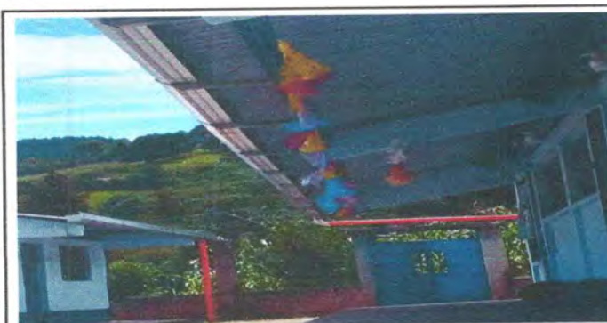
Foto 3: Sustitución de bajada de agua pluvial, tubo pvc 3"
