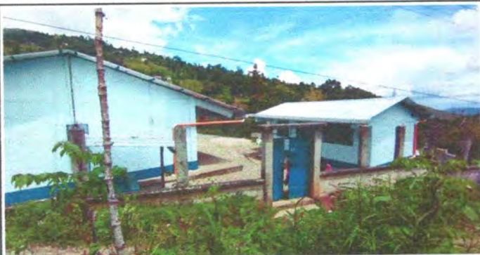
Foto 1: Sustitución de portón de metal 2.50 alto x 3 mts ancho
