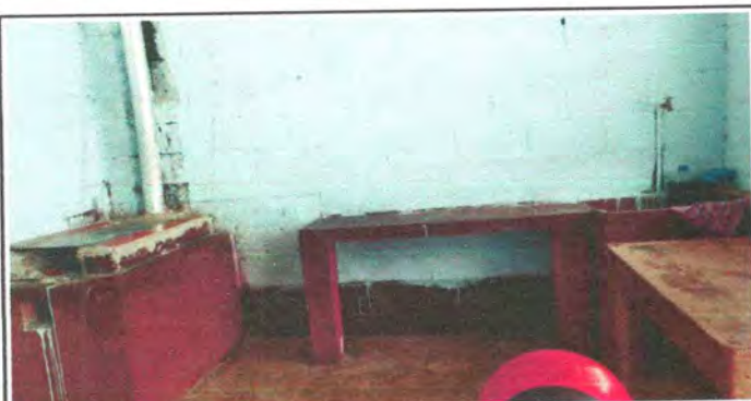
Foto 9: Repello en muro
