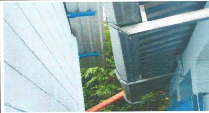
Foto 2: Sustitución de canal de pvc
