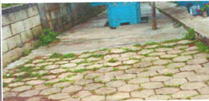
Foto 7: Sustrucción de adoquín por torta de cemento en patio
