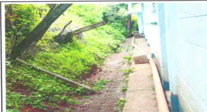
Foto 4: Sustitución de banqueta de concreto
