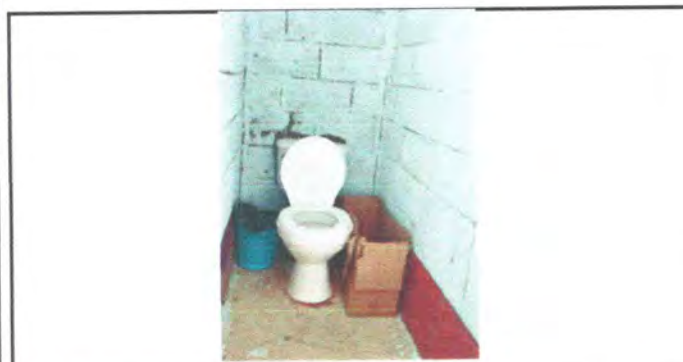
Foto 5: Sustitución de azulejo en baños
