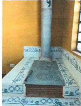
Foto19: Sustitucion de estufa rural (Completa incluye chimenea y plancha de metal)
