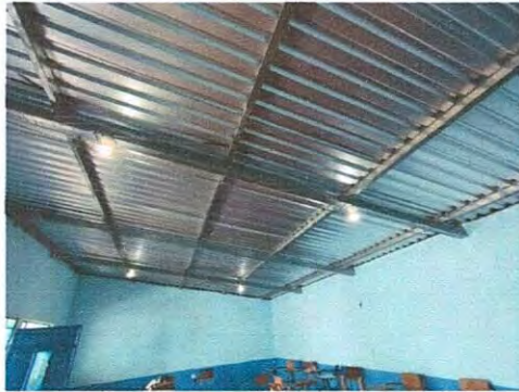
Foto 13: sustitución de lámparas tipo led por focos
