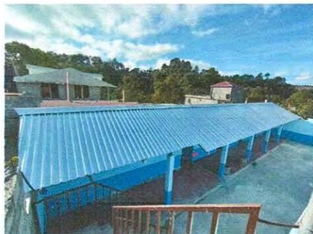
Foto1: sustitución de lámina, por lámina troquelada
