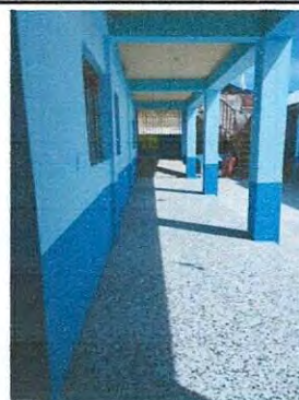
10. Pintura en muros exteriores e interiores
