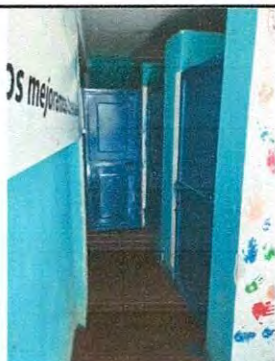
Foto 5: sustitución de puerta en servicios sanitarios
