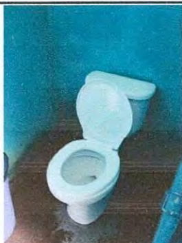
Foto 11: Sustitución de inodoros
