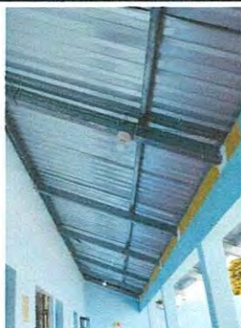
Foto 3: sustitución de estructura de soporte de madera por metal
