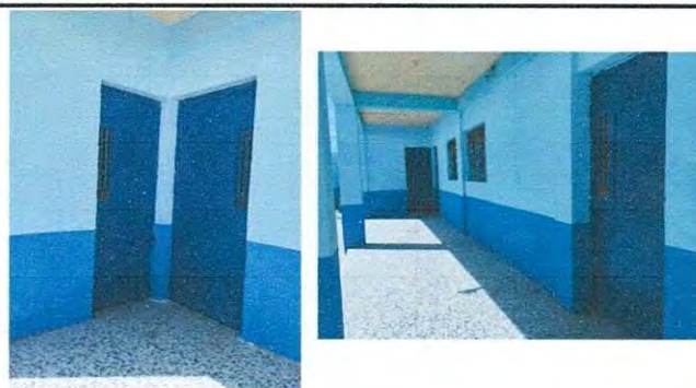
Foto 4: sustitución de puerta
