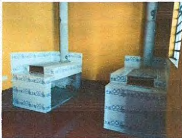
Foto19: Sustitucion de estufa rural (Completa incluye chimenea y plancha de metal)
