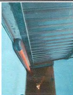
Foto 9: Reparación de bajada de agua pluvial tubo PVC
