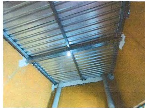
Foto 14: Sustitución de plafoneras
