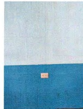
Foto 16: Sustitución tomacorrientes dobles
