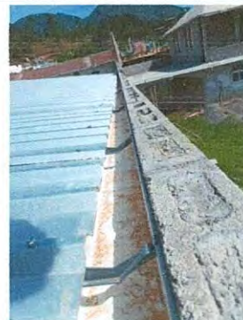
Foto 8: Sustitución de canal de metal
