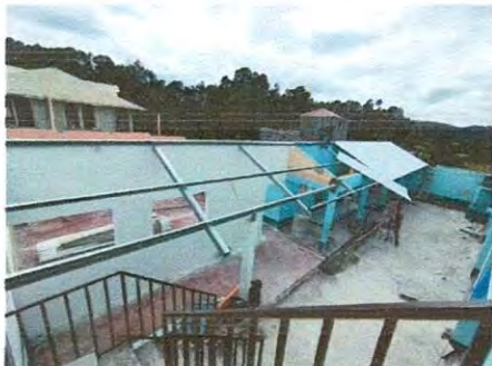
Foto1: sustitución de lámina, por lámina troquelada
