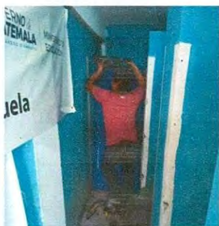
Foto 5: sustitución de puerta en servicios sanitarios
