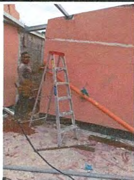
Foto 9: Reparación de bajada de agua pluvial tubo PVC
