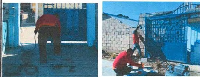
foto 12: Mantenimiento a portones de metal
