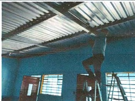
Foto13: sustitución de lámparas tipo led por focos
