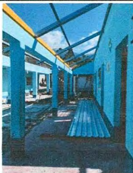
Foto 3: sustitución de estructura de soporte de madera por metal
