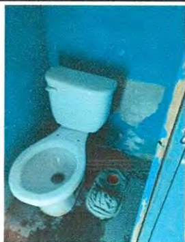
Foto 11: Sustitución de inodoros
