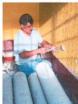
Foto 16: Sustitución tomacorrientes dobles
