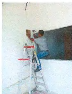
Foto 17: Sustitución de filipon
