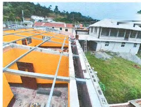
Foto 8: Sustitución de canal de metal
