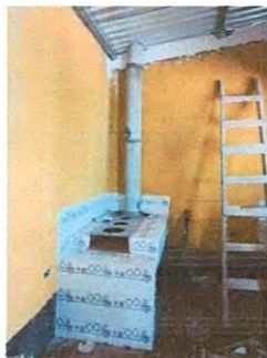
Foto19: Sustitucion de estufa rural (Completa incluye chimenea y plancha de metal)
