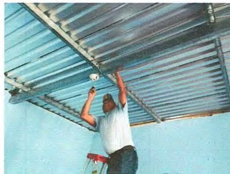
Foto 14: Sustitución de plafoneras
