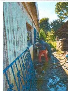
Foto 6: Mejoramiento en balcones de metal
