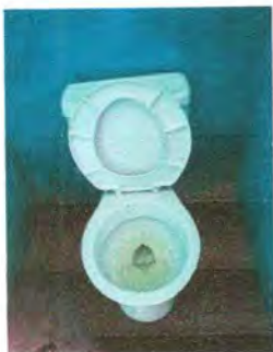
Foto 11: Sustitución de inodoros
