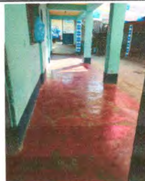
10. Pintura en muros exteriores e interiores
