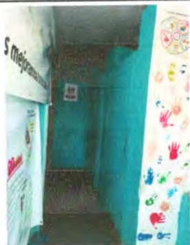
Foto 5: sustitución de puerta en servicios sanitarios
