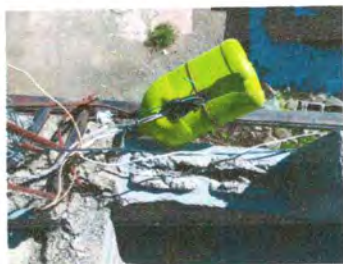
Foto 17: Sustitución de flipon
