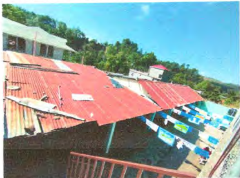
Foto 1: sustitución de lamina, por lamina troquelada
