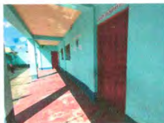
Foto 4: sustitución de puerta
