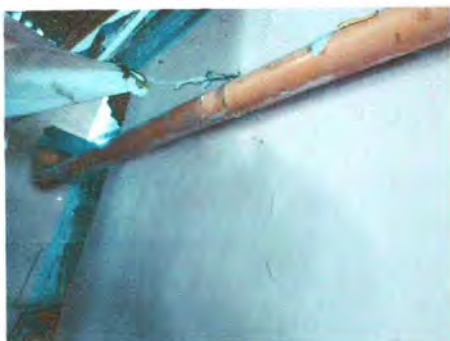
Foto 9: Reparación de bajada de agua pluvial tubo PVC
