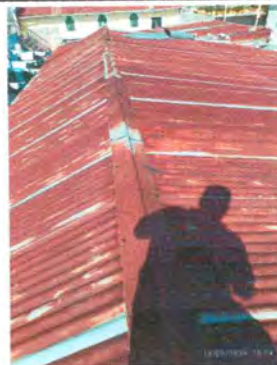
Foto 2: sustitución de capote de lamina, para lamina triquelada.
