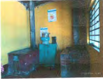
Foto19: Sustitucion de estufa rural (Completa incluye chimenea y plancha de metal)
