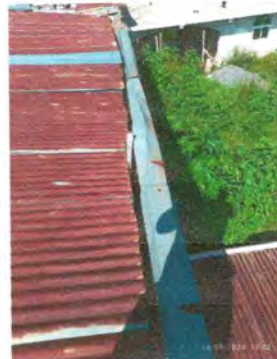
Foto 8: Sustitución de canal de metal
