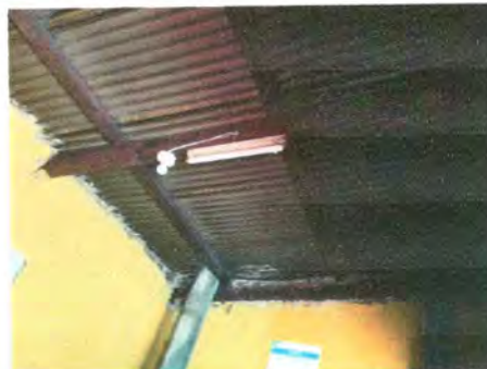
Foto 14: Sustitución de plafoneras
