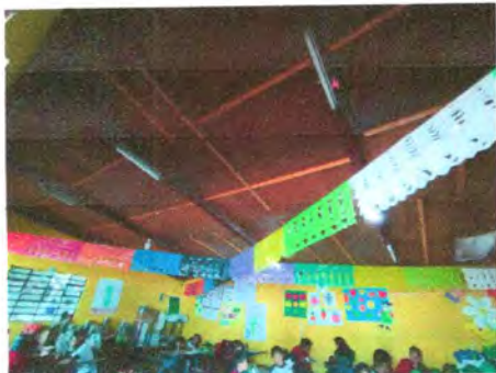
Foto 13: sustitución de lámparas tipo led por focos
