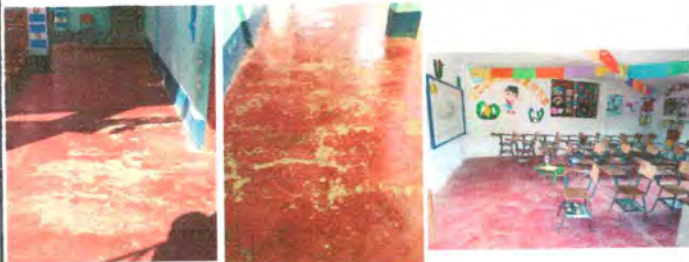
Foto7: Sustitución de piso de granito
