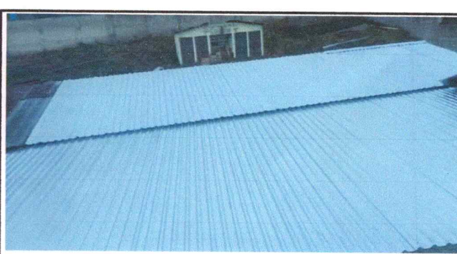
Foto 6: Cubierta de lámina para salón
