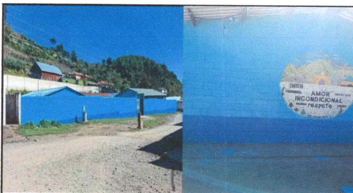
Foto 3: Pintura de exteriores e interiores
