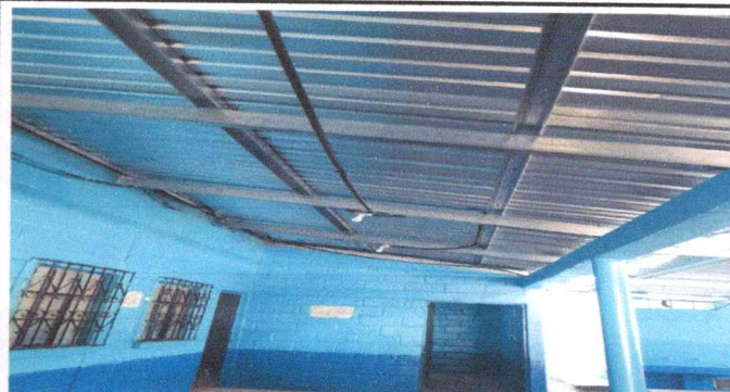
Foto 2: Cubierta de lámina
