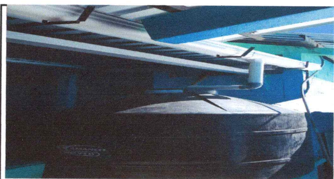
Foto 5: Cambio de canales
