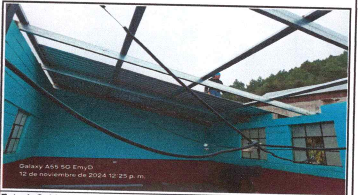
Foto 4: Cubierta de lámina de aulas
