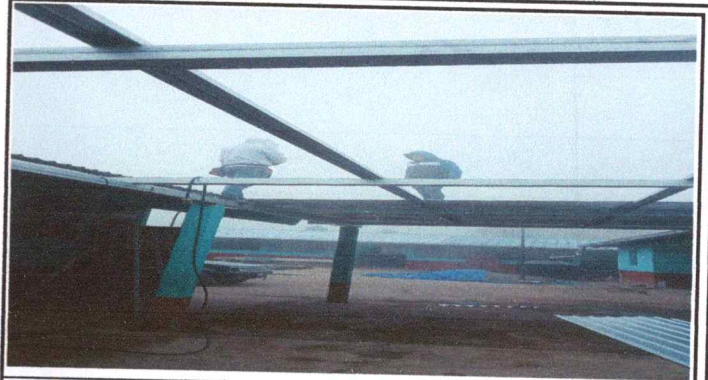
Foto 2: Cubierta de lámina
