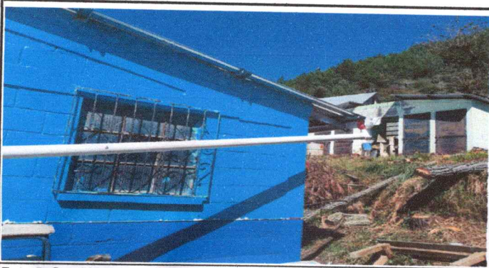
Foto 5: Cambio de canales
