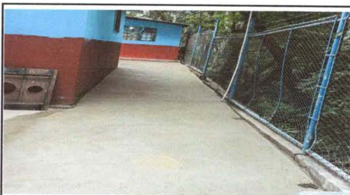
Foto 4: Reparación de planchas de concreto de patio
