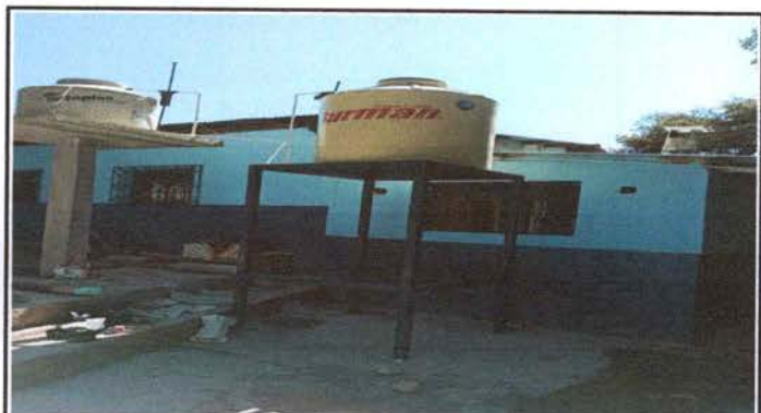
Foto 4: Instalación base para depósito de agua
