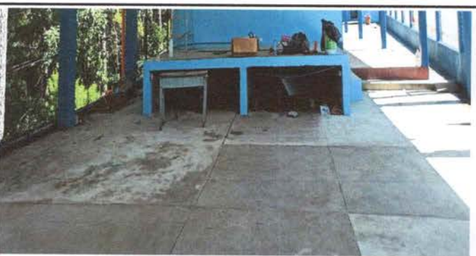
Foto 5: Reparación de planchas de concreto de patio
