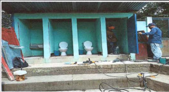
Foto 3: Sustitución de puertas de en servicios sanitarios
