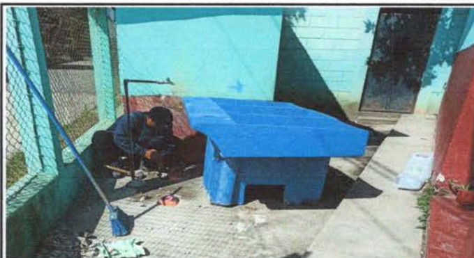
Foto 2: Sustitución de pilas de cemento de dos lavaderos
