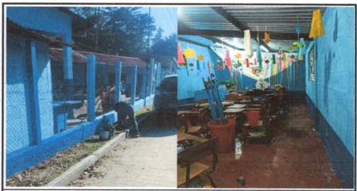
Foto 6: Pintura de muros exteriores e interiores
