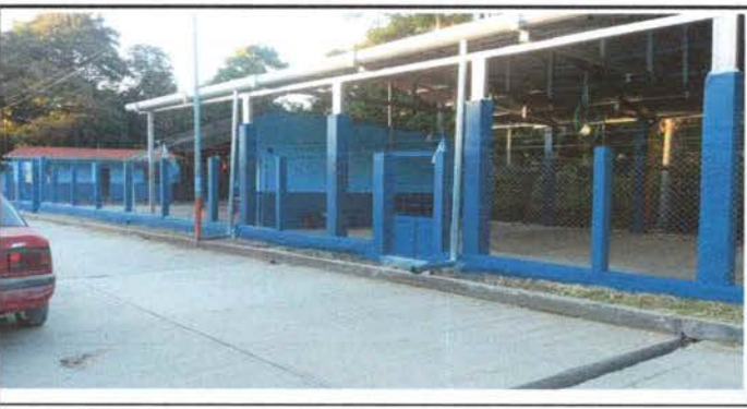
Foto 5: Mejoramiento de bajada de agua pluvial de metal por metal galvanizado
