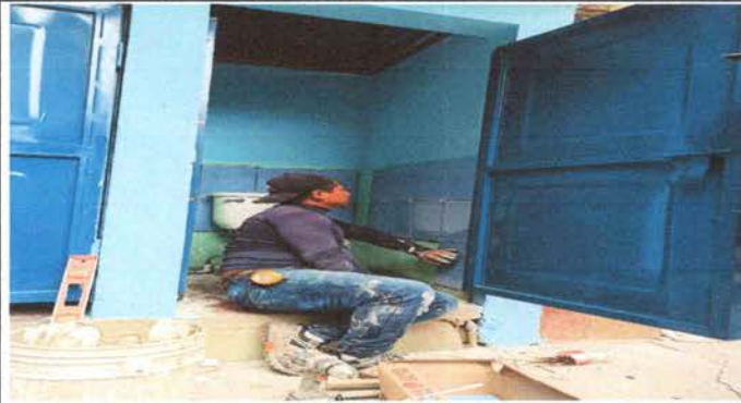
Foto1: Colocación de azulejo en baños
