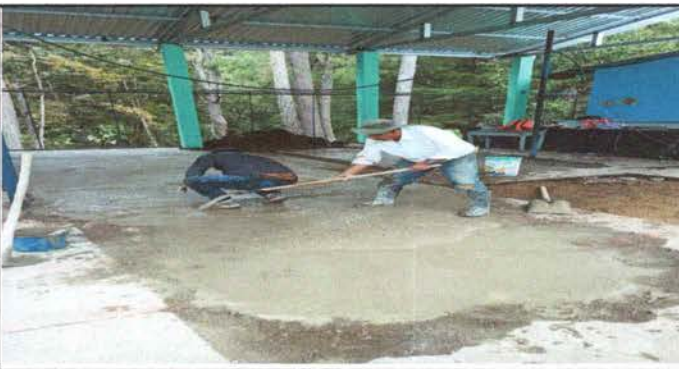
Foto 5: Reparación de planchas de concreto de patio
