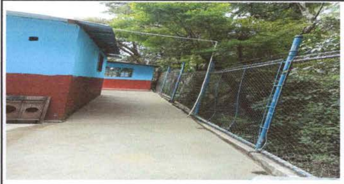
Foto 2: Sustitución de tubería línea principal
