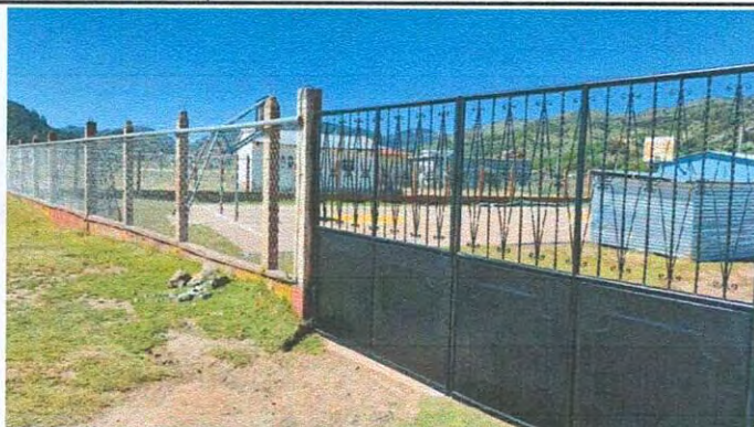
Foto 1: SUSTITUCION DE PORTON DE METAL POR PORTON DE METAL
