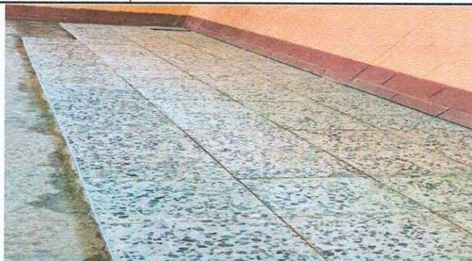
Foto 1: SUSTITUCIÓN DE CEMENTO LIQUIDO POR PISO DE GRANITO EN ÁREA DE AULAS
