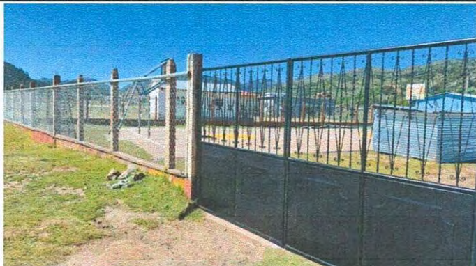
Foto 1: SUSTITUCION DE PORTON DE METAL POR PORTON DE METAL
