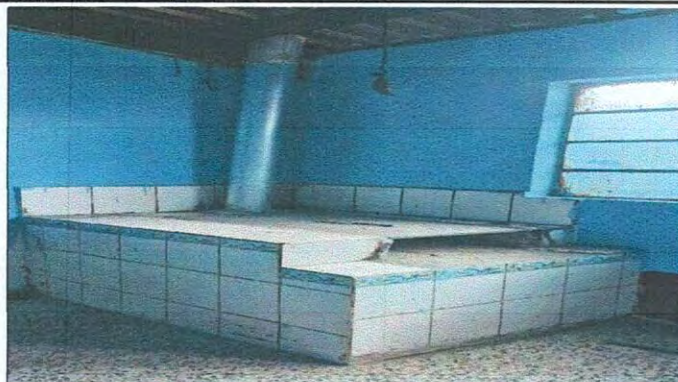
Foto 2: SUSTITUCIÓN DE PLANCHA DE ESTUFA RURAL
