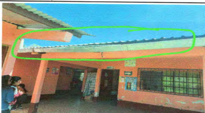
Foto 2: SUSTITUCIÓN DE CANAL DE METAL POR CANAL DE METAL
