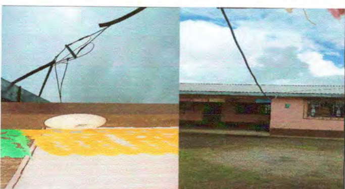
Foto 4: REPARACION DE SISTEMA ELÉCTRICO
