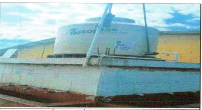
Foto 5: SUSTITUCIÓN DE DEPÓSITOS DE AGUA POR DEPÓSITO DE AGUA DE 1100 LITROS
