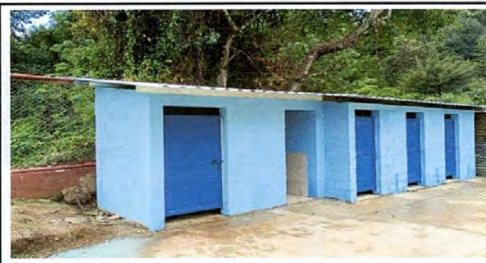
FOTO 3: Sustrucción de soporte de metal por metal en área de baños y sustrucción de lamina troquelada calibre 26
