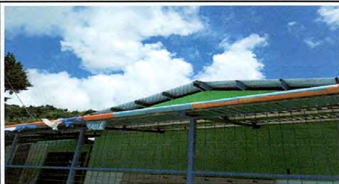
FOTO 1: Sustrucción de soporte de madera por metal (incluye costaneras, tubos de metal hg) de área de lavamanos y sustrucción de lamina troquelada calibre 26
