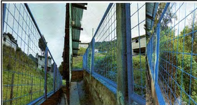
FOTO 8: Sustitución de tubo hg y electromalla
