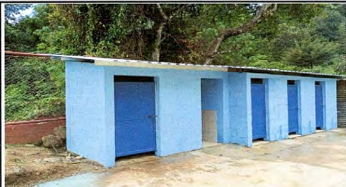
FOTO 4: Sustrucción de puertas en servicios sanitarios
