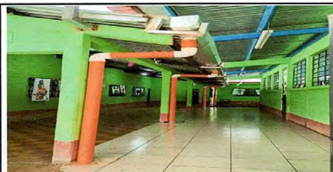
FOTO 5: Sustrucción de canal de metal (incluye soporte)
