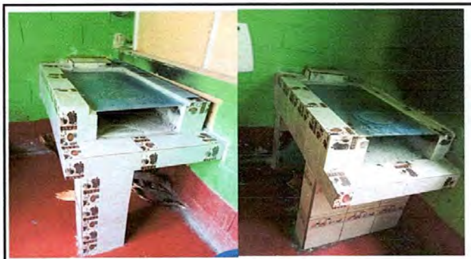
FOTO 10: Sustitución de plancha de metal de 3 hornillas
