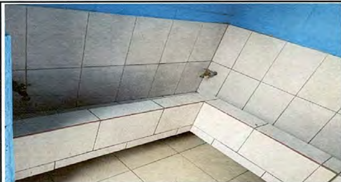
FOTO 7: REPARACIÓN O SUSTITUCIÓN DE AZULEJO
