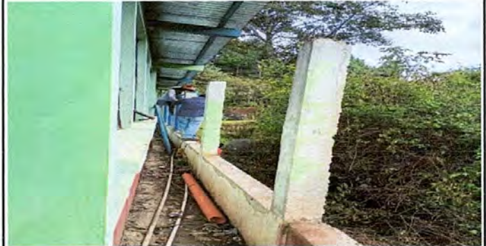
FOTO 8: Sustitución de tubo hg y electromalla
