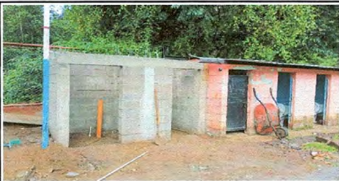
FOTO 3: Sustrucción de soporte de metal por metal en área de baños y sustrucción de lamina troquelada calibre 26
