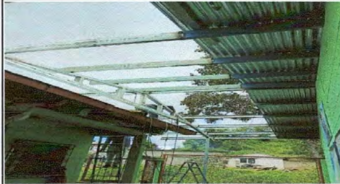
FOTO 2: Ampliación de soporte de metal en área de aula (incluye costaneras, postes de hierro hg) y sustrucción de lamina troquelada calibre 26
