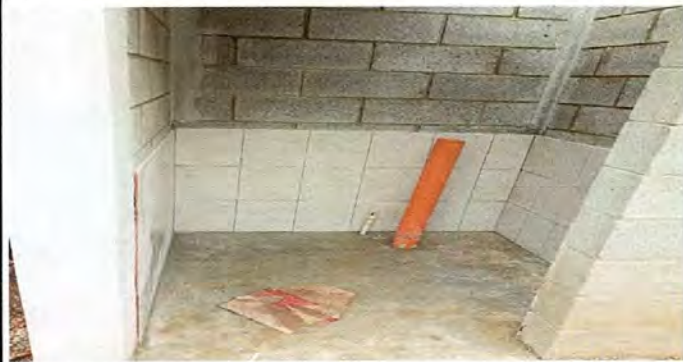
FOTO 7: REPARACIÓN O SUSTITUCIÓN DE AZULEJO
