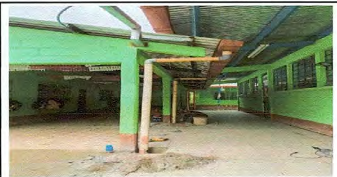
FOTO 5: Sustrucción de canal de metal (incluye soporte)
