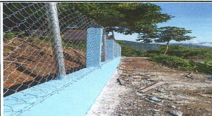
Foto 1. Reparación de muro perimetral: la EORM Aldea Buena Vista San Isidro está completamente circulada con el muro perimetral de block, tubo hg, malla galvanizada, soleras intermedias y columnas.
