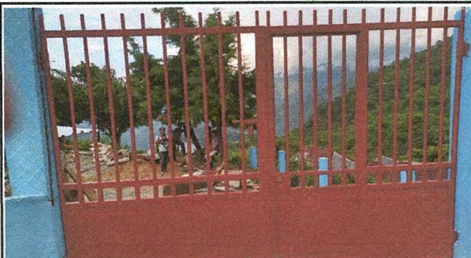
Foto 3: Puertas de metal: el ingreso al centro educativo ya posee el portón de acceso general para tener una mayor seguridad para los alumnos dentro de las instalaciones educativas.
