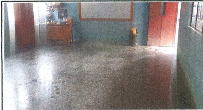
Foto 2. Sustitución de piso: las aulas de la EORM Aldea Buena Vista ya poseen un piso de granito para brindar un mejor ambiente educativo para los alumnos.
