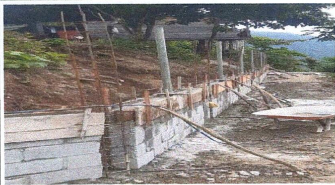
Foto 1. Reparación de muro perimetral: fundición de las soleras intermedias del muro perimetral de la EORM Aldea Buena Vista San Isidro, Chiantla.
