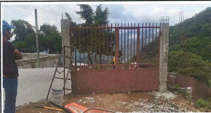
Foto 3. Puertas de metal: instalando el porton de ingreso al centro educativo.
