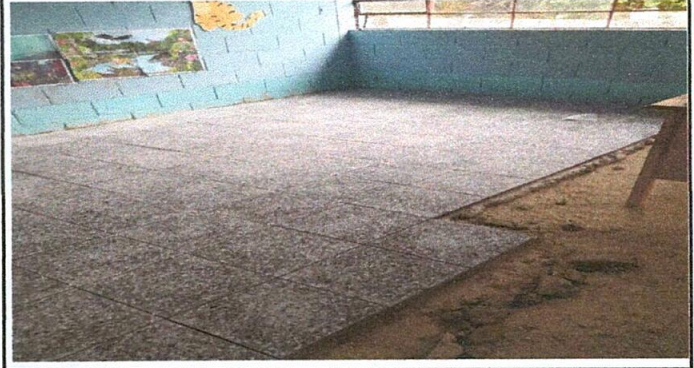
Foto 2. Sustitución de piso: colocando el piso de granito en los salones de clase de la EORM Aldea Buena Vista San Isidro, Chiantla.
