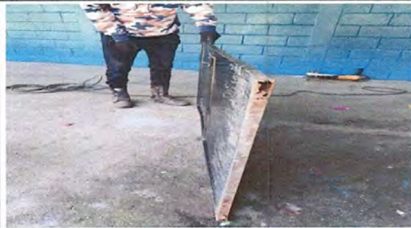
FOTO 13: SUSTITUCION DE PUERTA DE METAL DE BAÑO DE ALUMNOS.
