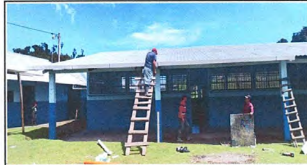
FOTO 12: SUSTITUCIÓN DE CANALES PVC, PESCANTE Y TUBOS PVC DE BAJADAS DE AGUA DE LLUVIA.
