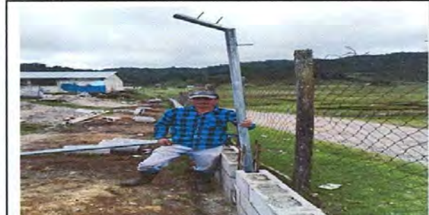
FOTO 6: FUNDICION DE BLOCK Y TUBO HG PARA LA MALLA GALVANIZADA.
