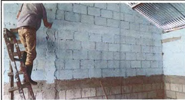
FOTO 9: PINTURA EN SALÓN.
