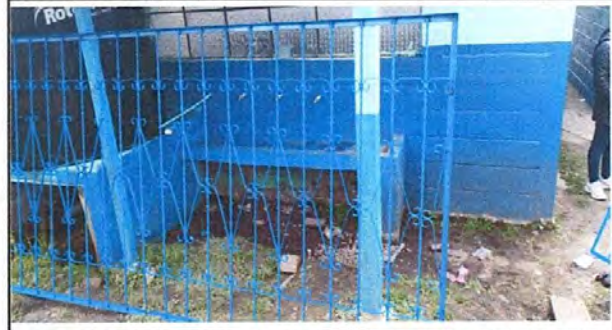
FOTO 14: SUSTITUCION DE BALCONES (ADELANTE Y ATRÁS) DE UN AULA.
