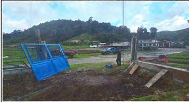
FOTO 1: FABRICACION DE PORTON DE METAL.
