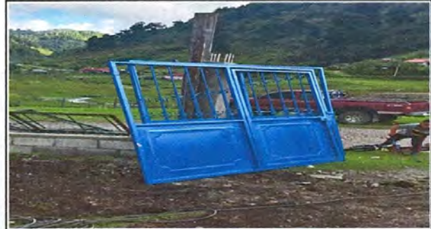
FOTO 2: INSTALACION DE PORTON DE METAL.
