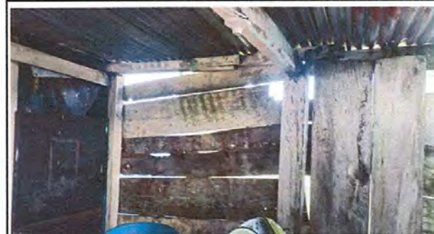
FOTO 16: SUSTITUCION DE MURO DE MADERA POR MURO DE BLOCK.
