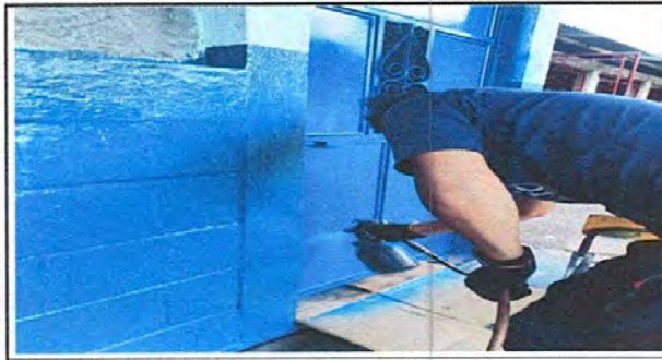
FOTO 11: MANTENIMIENTO DE PUERTAS DE METAL.
