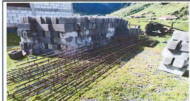
FOTO 4: ELABORACION DE ESTRUCTURA DE HIERRO PARA MURO PERIMETRAL.
