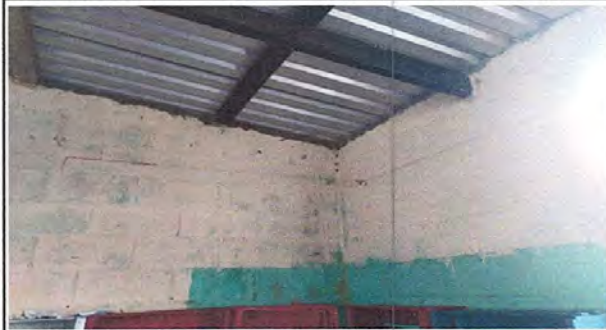
FOTO 7: PINTURA EN INTERIORES DE AULAS.
