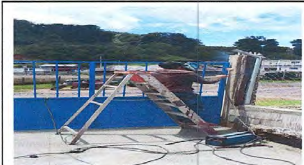
FOTO 3: SOLDADURA DE PORTON DE METAL.
