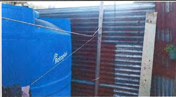
FOTO 15: SUSTITUCION DE MURO DE LAMINA POR BLOCK.
