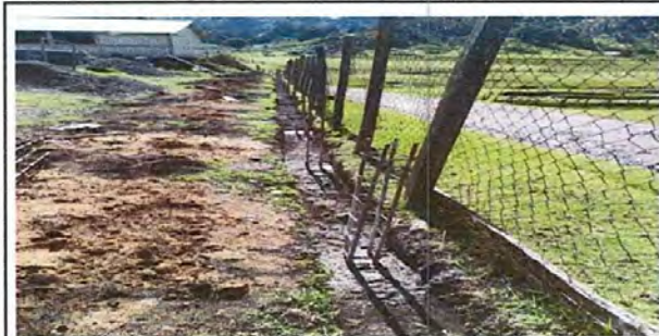
FOTO 5: FUNDICION DE HIERRO PARA MURO PERIMETRAL.
