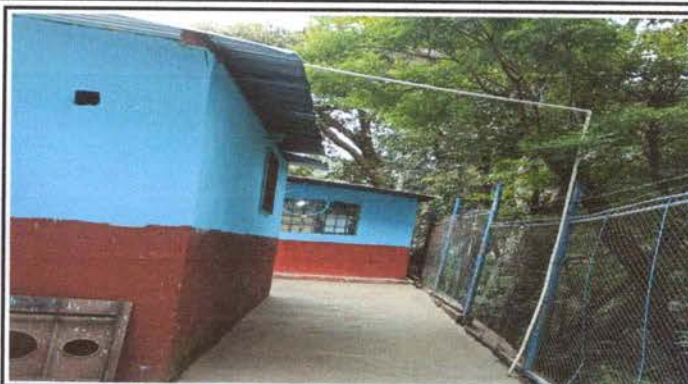
Foto 2: Sustitución de tubería línea principal
