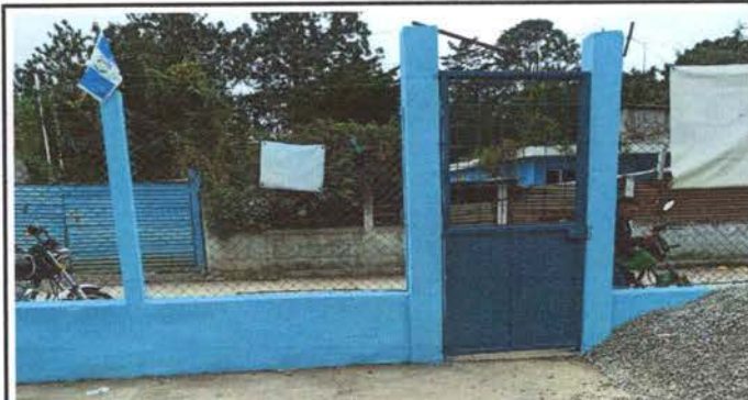
Foto 4: Sustitución de puertas de entrada a la escuela
