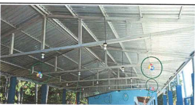
Foto 6: Sustitución ducto eléctrico mas accesorios
