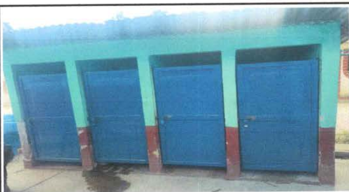
Foto 3: Sustitución de puertas de en servicios sanitarios
