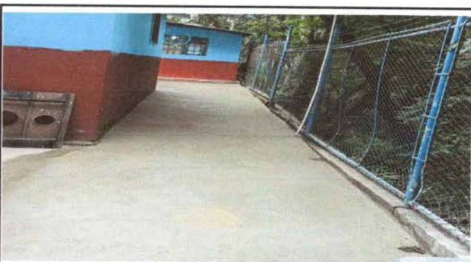
Foto 4: Reparación de planchas de concreto de patio
