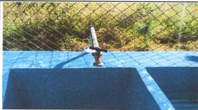
Foto 3: Sustitución de chorros
