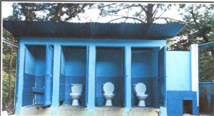
Foto1: Colocación de azulejo en baños
