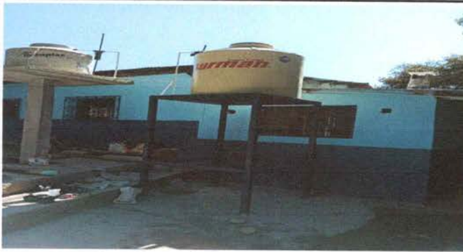
Foto 1: Sustitución de depósito de agua 1700 litros con accesorios
