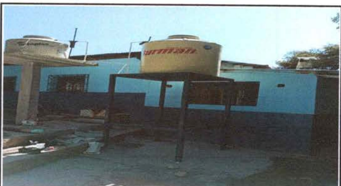
Foto 4: Instalación base para depósito de agua
