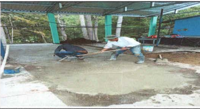
Foto 5: Reparación de planchas de concreto de patio
