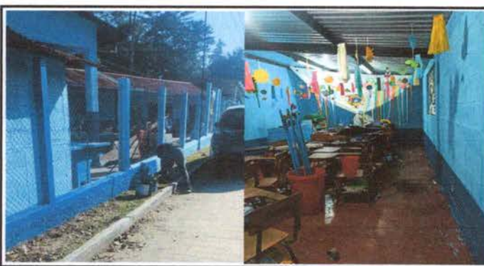
Foto 6: Pintura de muros exteriores e interiores
