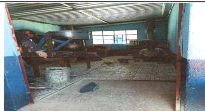
Foto 3: Sustitución de piso de torta de cemento por piso granito de cocina
