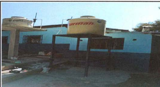
Foto 4: Instalación base para depósito de agua
