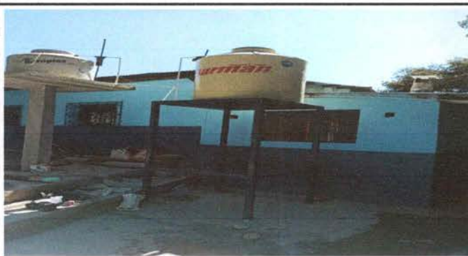
Foto1: Sustitución de deposito de agua 1700 litros con accesorios
