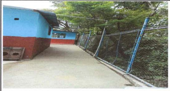
Foto 2: Sustitución de tubería línea principal
