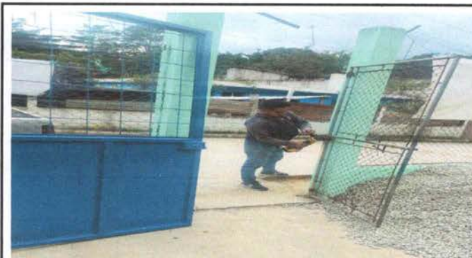
Foto 4: Sustitución de puertas de entrada a la escuela
