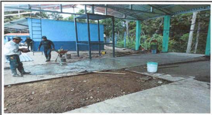
Foto 4: Reparación de planchas de concreto de patio
