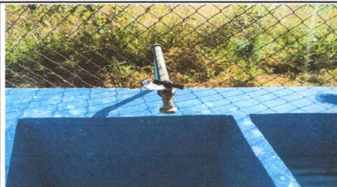
Foto 3: Sustitución de chorros
