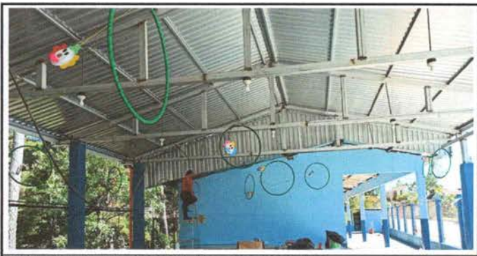
Foto 6: Sustitución ducto eléctrico mas accesorios
