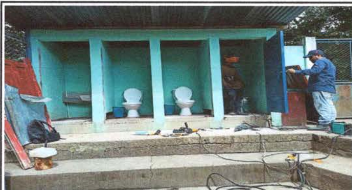
Foto 3: Sustitución de puertas de en servicios sanitarios
