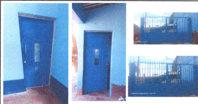
Foto 2: Puertas de Metal: Sustitución de puertas de madera y porton.
