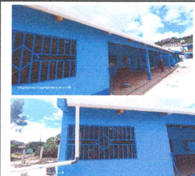
Foto 4: Canales y Bajadas de agua pluvial. Sustitución de canal de PVC, bajas de agua y soportes.
