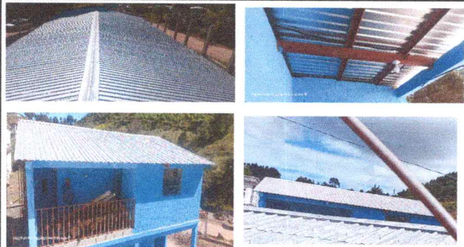
Foto 1: Cubierta de Lámina: sustitución de lámina, por lamina troquelada aluzinc calibre 26
