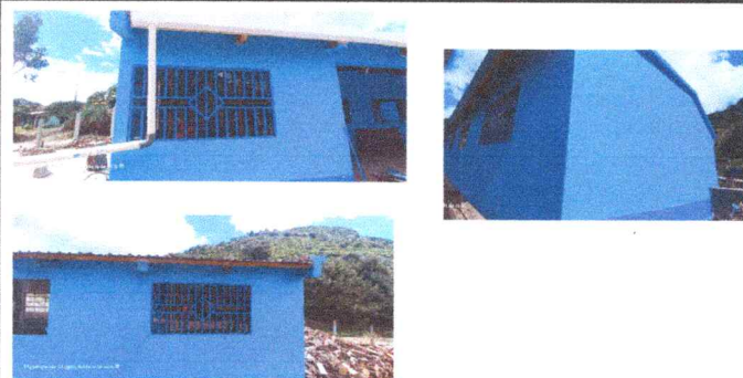
Foto 3: Ventanas: Sustitución de vidrios y balcones.
