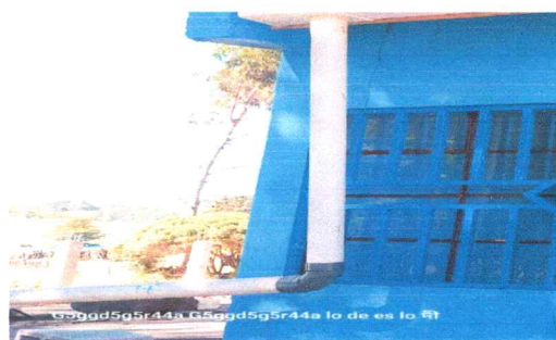
Foto 4: Canales y Bajadas de agua pluvial. Sustitución de canal de PVC, bajas de agua y soportes.
