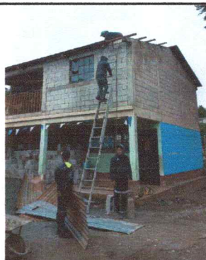
Foto1: Cubierta de Lámina: sustitución de lámina, por lamina troquelada aluzinc calibre 26
