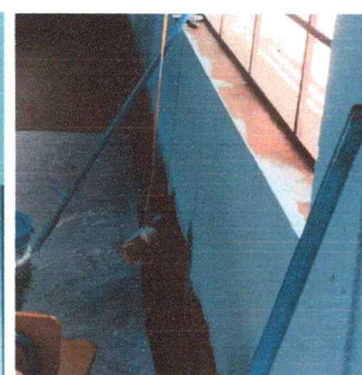
Foto 4: Canales y Bajadas de agua pluvial. Sustitución de canal de PVC, bajas de agua y soportes.
