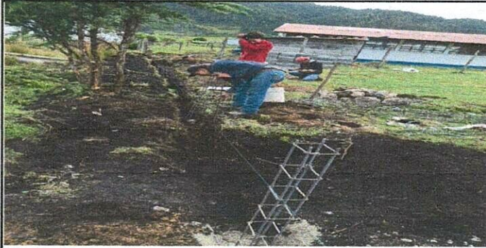
FOTO 1 TRABAJO DEL MURO PERIMETRAL
