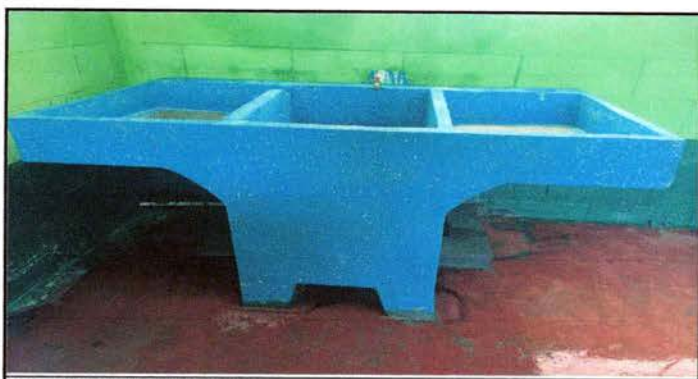
Foto: 11 Sustitución de Pila
