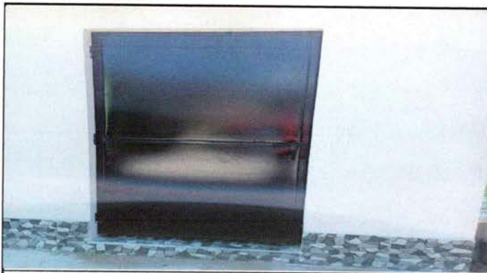
Foto: 3 Puertas de Metal
