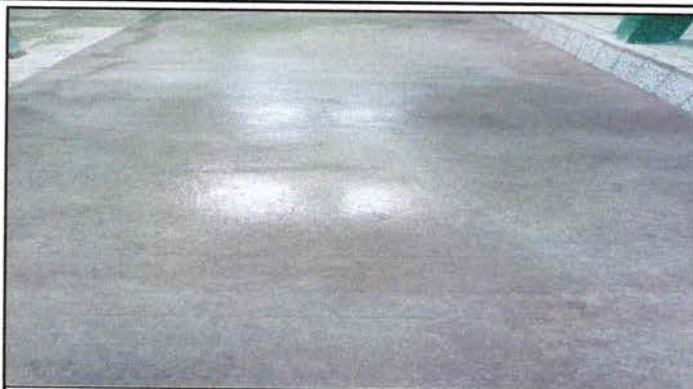
Foto: 8 Losa de Patio
