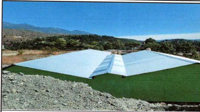
Foto: 1 Sustitución de Lámina
