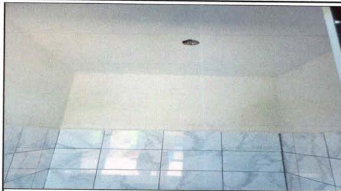
Foto: 7 Mejoramiento de Paredes de Baño
