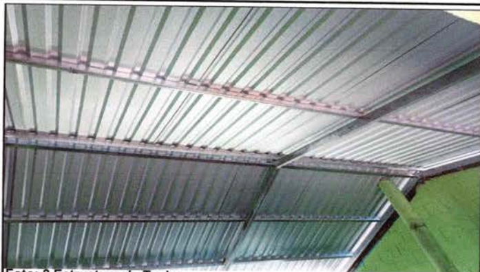
Foto: 2 Estructura de Techo
