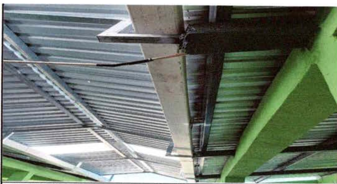
Foto: 5 Canles y Bajadas de Agua Pluvial
