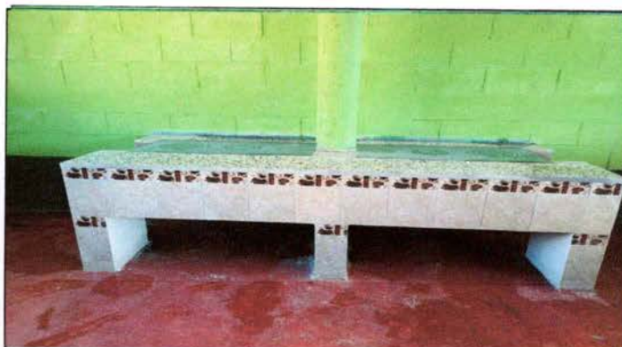
Foto: 10 Reparación de cocina
