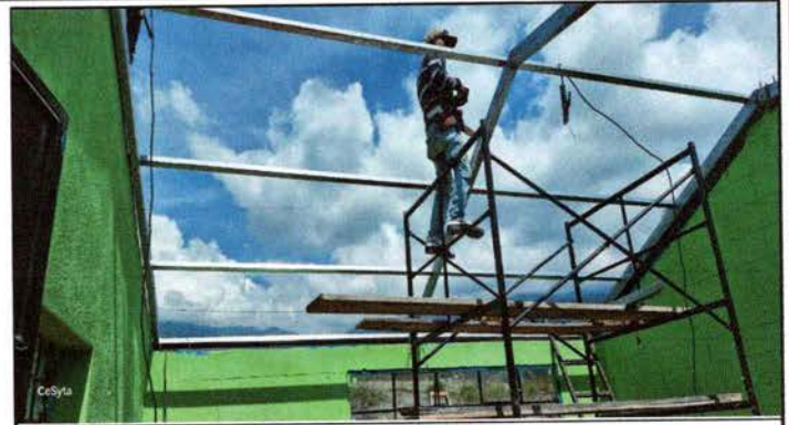
Foto: 2 Estructura de Techo
