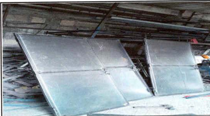
Foto: 3 Puertas de Metal
