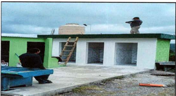
Foto: 9 Reparación y Mantenimiento de Cisternas /Deposito de Agua
