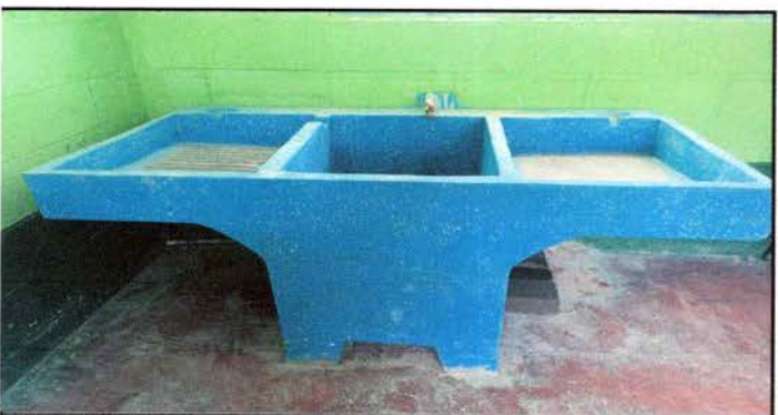
Foto: 11 Sustitución de Pila
