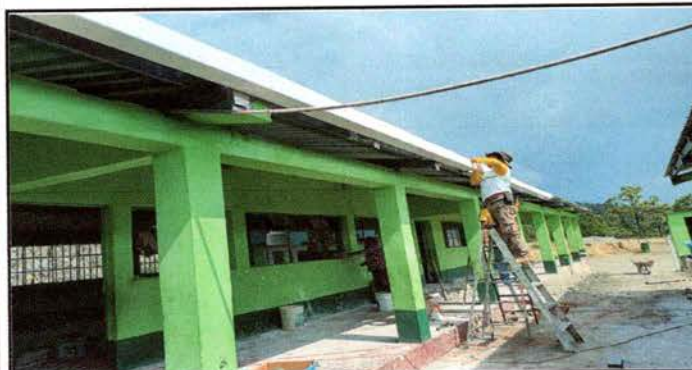
Foto: 5 Canles y Bajadas de Agua Pluvial
