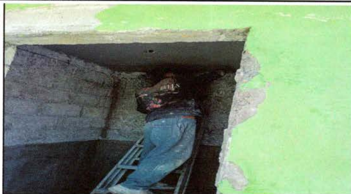
Foto: 7 Mejoramiento de Paredes de Baño
