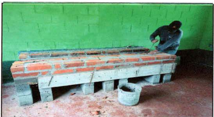
Foto: 10 Reparación de cocina
