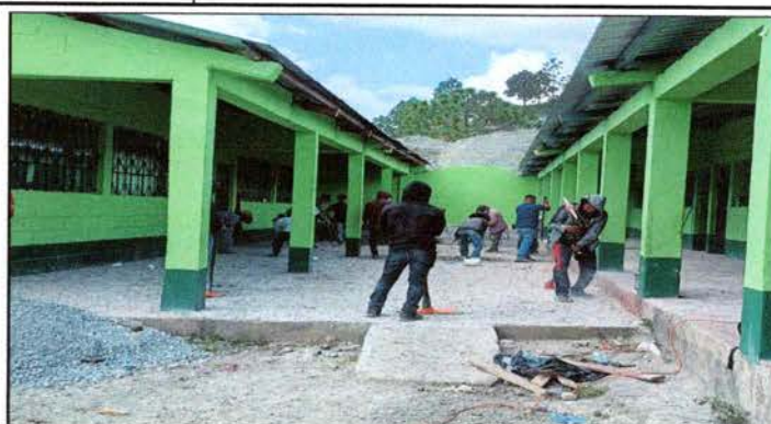
Foto: 8 Losa de Patio
