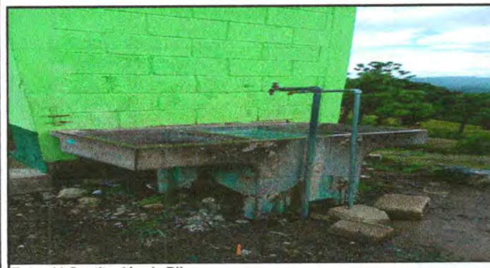
Foto: 11 Sustitución de Pila
