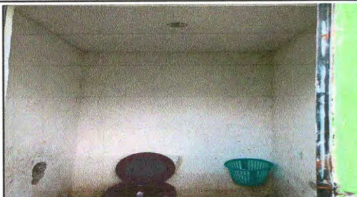
Foto: 7 Mejoramiento de Paredes de Baño
