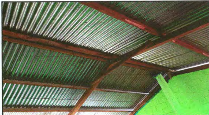
Foto: 2 Estructura de Techo
