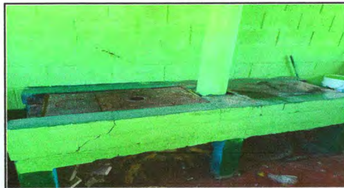
Foto: 10 Reparación de cocina
