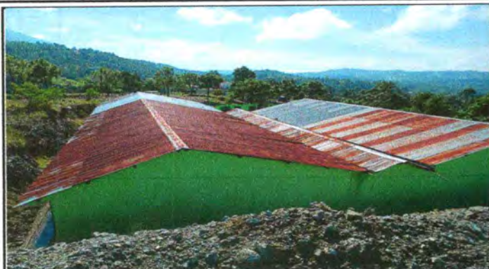
Foto: 1 Sustitución de Lámina
