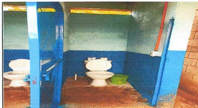
Foto 6: Sustitución de Inodoros
