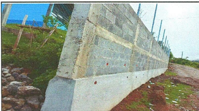
Foto 2: Reparación de muro de contención
