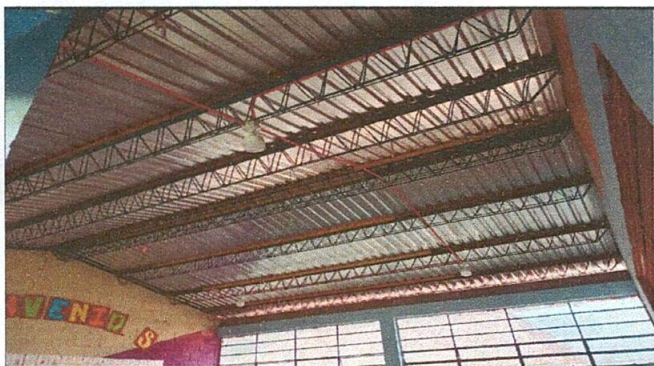
Foto 3: Reparación del sistema Eléctrico
