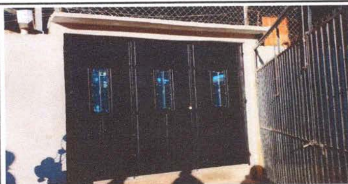
Foto 5: Sustitución de portón de metal 2.20 alto x 3 mts ancho
