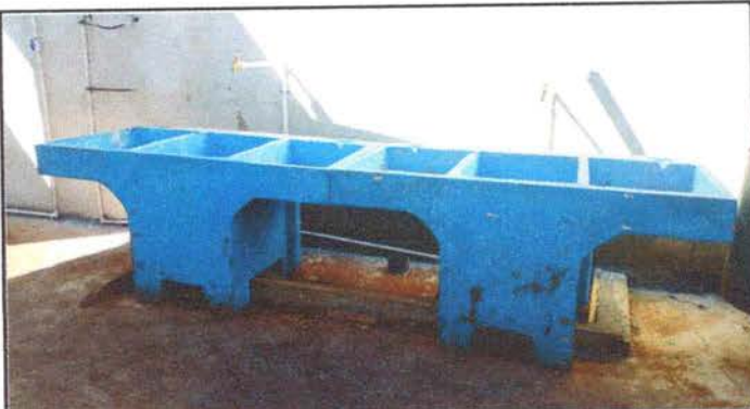
Foto 21: Sustitución de pilas de concreto
