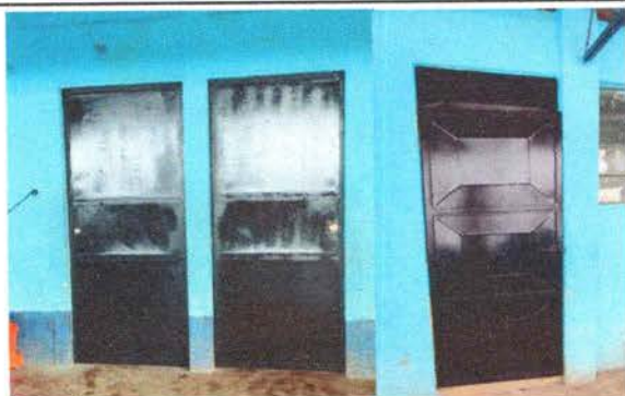
Foto 3: Mantenimiento a estructura (lijado, cepillado, sujeciones, aplicación de pintura)
