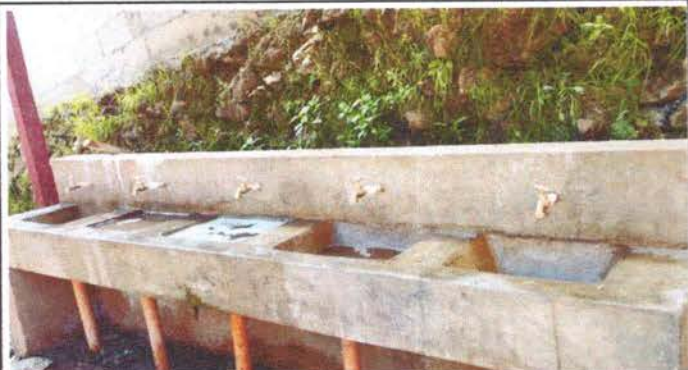
Foto 13: Sustrucción de llave de chorro
