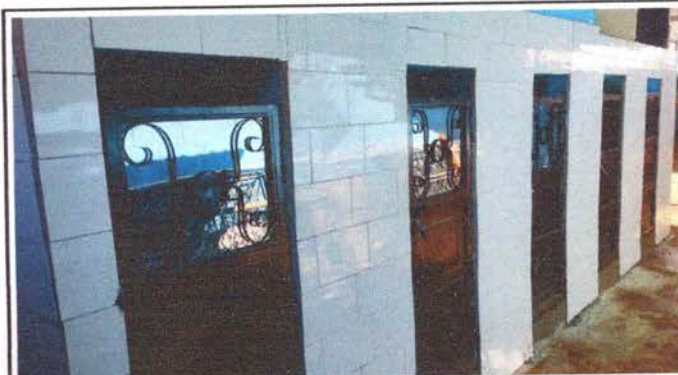
Foto 10: Reparación o sustitución de azulejo
