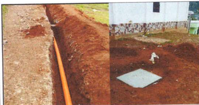
Foto 11: Reparación de red de drenaje
