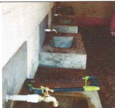
Foto 14: Sustrucción de llave de chorro
