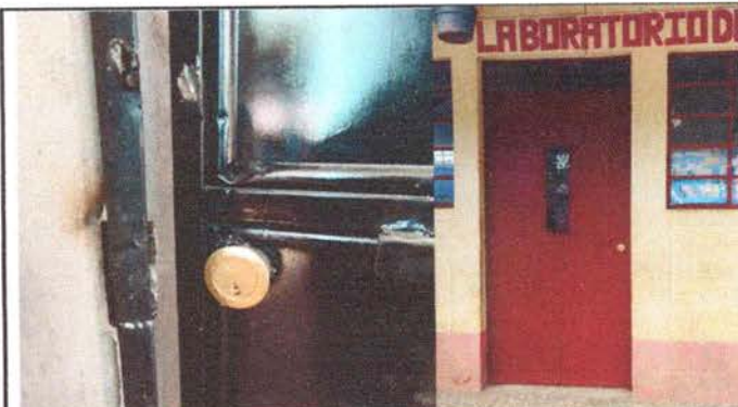
Foto 4: Sustitución de chapa
