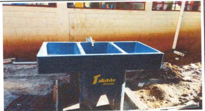
Foto 22: Sustitución de pila de plástico
