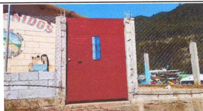
Foto 6: Sustitución de portón de metal 2.20 alto x 1.50 mts
