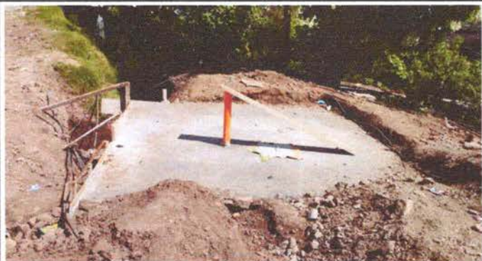
Foto 25: Fundición de tapadera de fosa séptica
