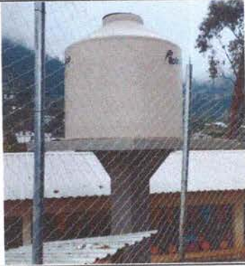
Foto 19: Sustitución de depósito de agua de 2,500 litros
