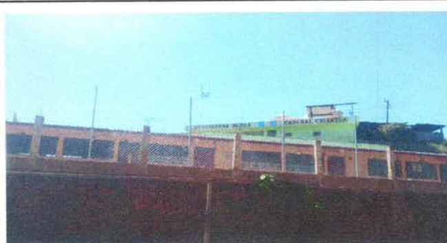
Foto 16: Reparación de tubo hg y malla galvanizada
