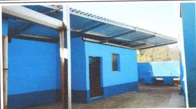
Foto 8: Pintura en muros exteriores e interiores
