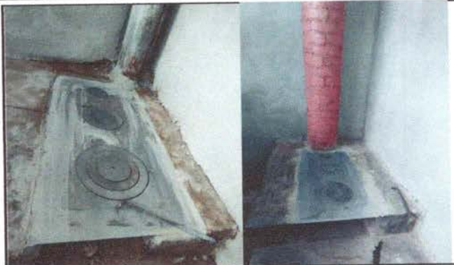
Foto 20: Sustitución de planchas de metal de 3 hornillas
