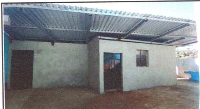
Foto 24: Reparación de repello y cernido de paredes
