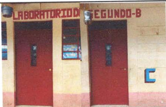
Foto 23: Mantenimiento a estructura (lijado, cepillado, sujeciones, aplicación de pintura)
