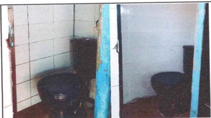
Foto 9: Sustitución de inodoros
