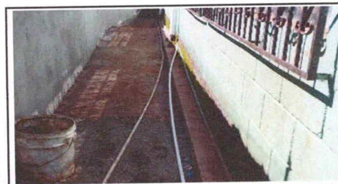
Foto 12: Sustitución de tubería línea principal
