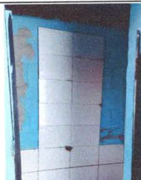
Foto 10: Reparación o sustitución de azulejo
