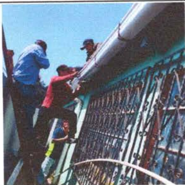
Foto 7: Sustitución de canal de pvc y reparación de bajada de agua pluvial
