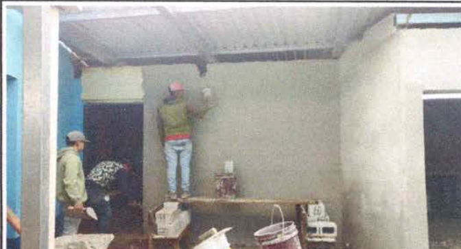
Foto 22: Reparación de repello y cernido de paredes
