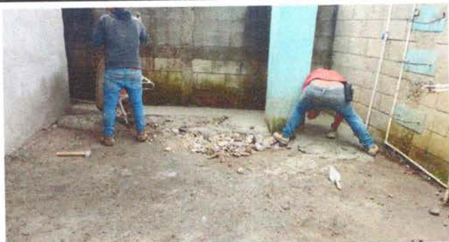
Foto 17: Reparación de planchas de concreto de patio
