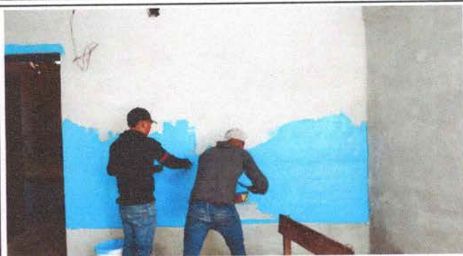
Foto 8: Pintura en muros exteriores e interiores
