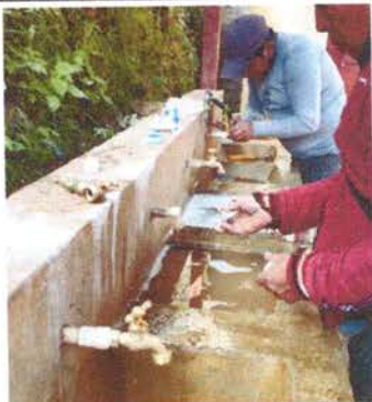
Foto 13: Sustitución de llave de chorro
