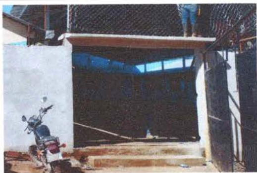
Foto 5: Sustitución de portón de metal 2.20 alto x 3 mts ancho
