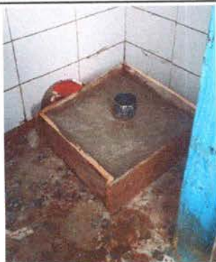
Foto 9: Sustitución de inodoros
