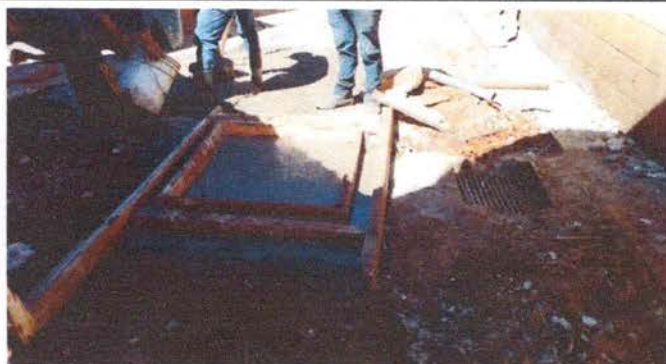
Foto 21: Sustitución de pllas
