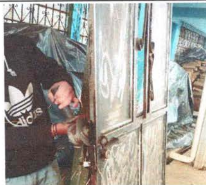
Foto 4: Sustitución de chapa
