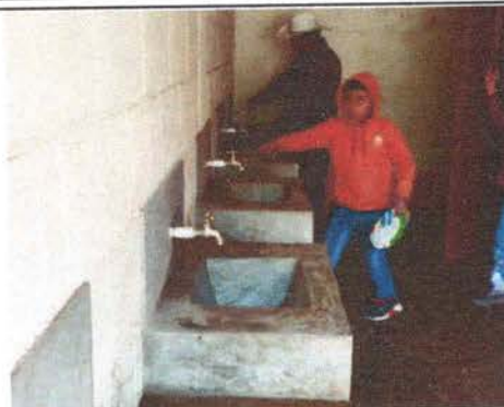
Foto 14: Sustitución de llave de chorro
