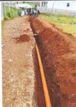
Foto 11: Reparación de red de drenaje
