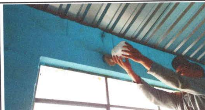
Foto 18: Sustitución de focos ahorradores
