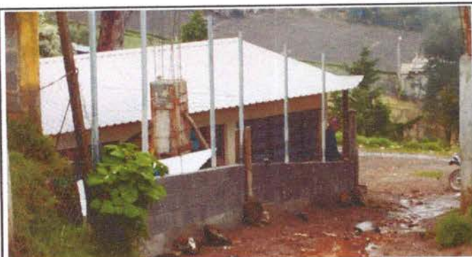
Foto 15: Sustitución de muro perimetral de block con tubo hg y malla galvanizada, soleras intermedias y columnas.
