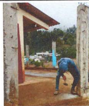
Foto 6: Sustitución de portón de metal 2.20 alto x 1.50 mts
