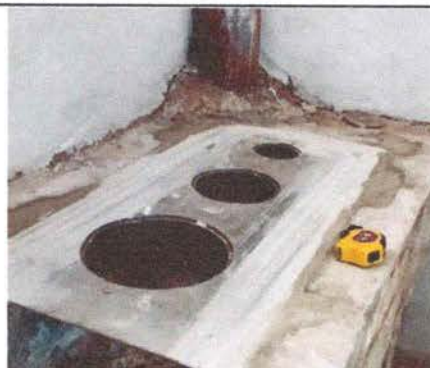
Foto 20: Sustitución de planchas de metal de 3 hornillas
