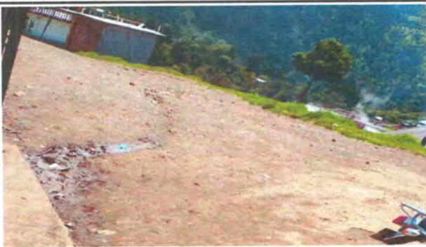
Foto 11: Reparación de red de drenaje
