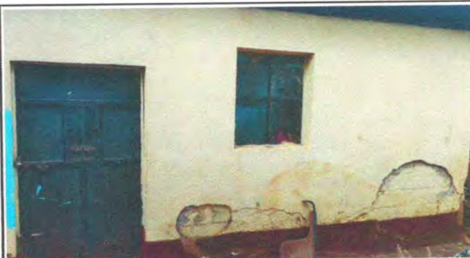
Foto 22: Reparación de repello y cernido de paredes
