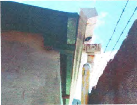
Foto 7: Sustrucción de canal de pvc y reparación de bajada de agua pluvial
