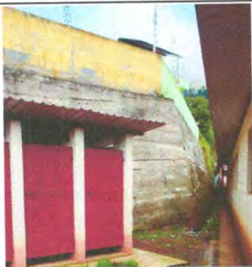
Foto 19: Sustitución de depósito de agua de 2,500 litros
