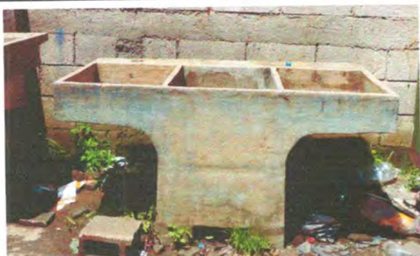
Foto 21: Sustitución de pilas
