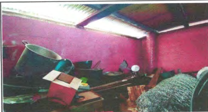
Foto 20: Sustitución de planchas de metal de 3 hornillas
