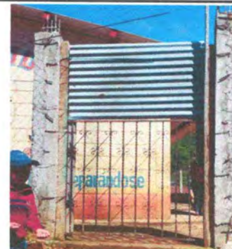
Foto 6: Sustitución de portón de metal 2.20 alto x 1.50 mts
