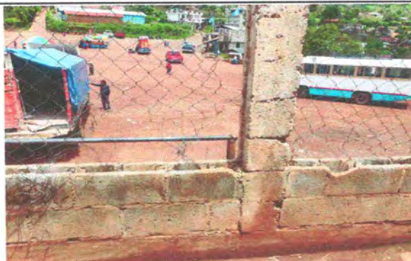
Foto 16: Reparación de tubo hg y malla galvanizada
