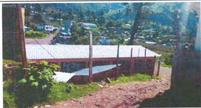
Foto 15: Sustrucción de muro perimetral de block con tubo hg y malla galvanizada, soleras intermedias y columnas.
