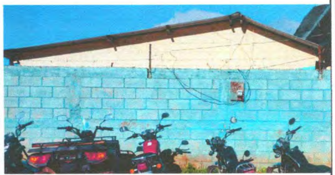
Foto 8: Pintura en muros exteriores e interiores
