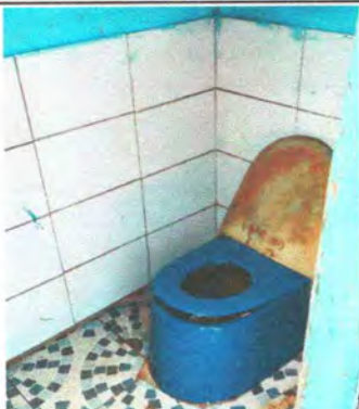
Foto 9: Sustrucción de inodoros
