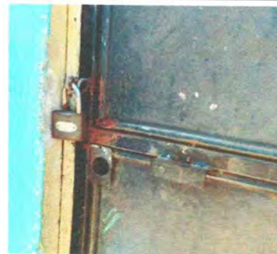
Foto 4: Sustitución de chapa
