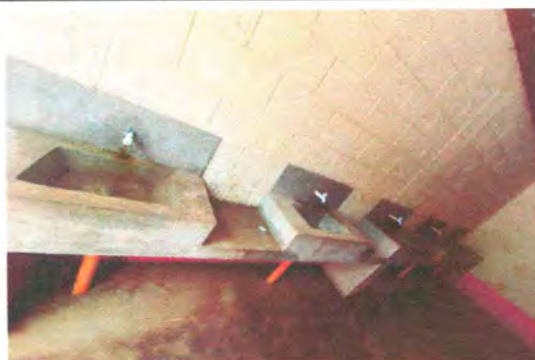
Foto 14: Sustrucción de llave de chorro
