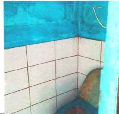
Foto 10: Reparación o sustitución de azulejo
