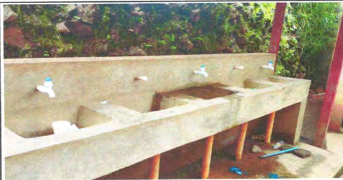
Foto 13: Sustrucción de llave de chorro
