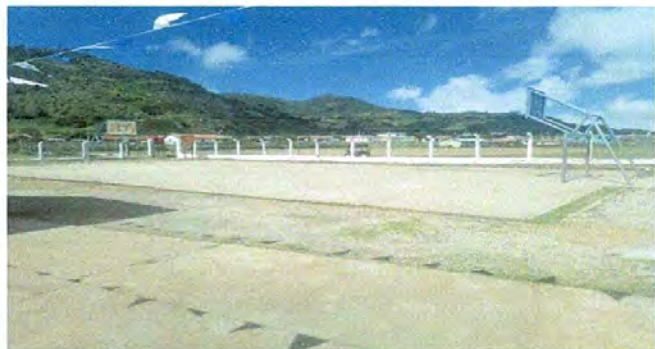
Foto 7: Pintura de muro perimetral
