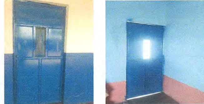
Foto 6: sustitución de puertas de madera por metal y pintura de puertas de metal
