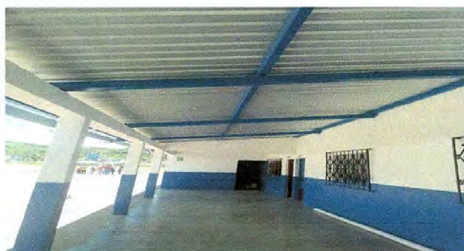
Foto 3: Sustitución de estructuras de soporte
