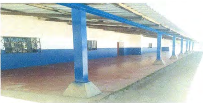
Foto 5: Sustitución de postes de soporte de madera por metal
