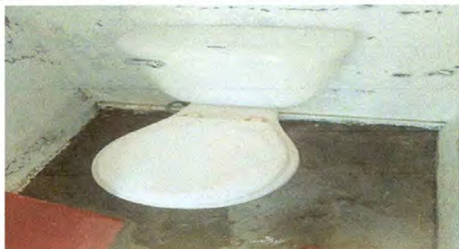
Foto 8: Cambio de tanque y tapadera de sanitario
