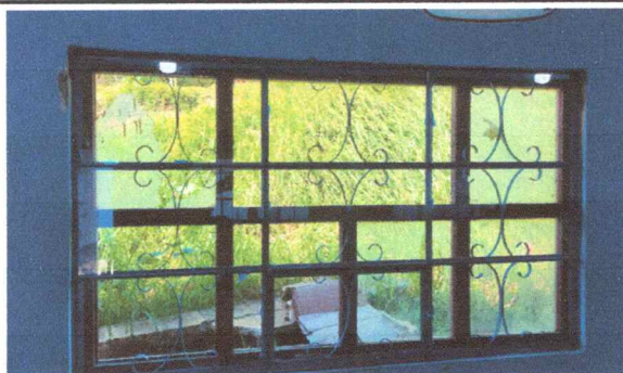
Foto 5: Sustitución de estructura de metal de ventana
