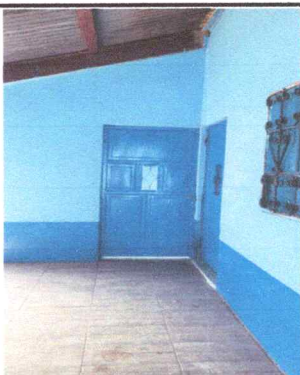
Foto 3: Sustitución de puertas
