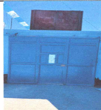
Foto 4: Sustitución de portón de metal
