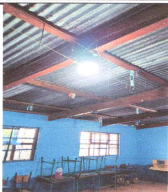
Foto 7: Sustitución de focos ahorradores
