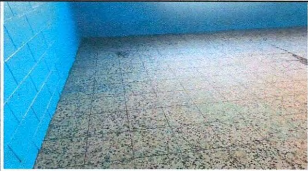
Foto 3: Sustitución de piso de granito
