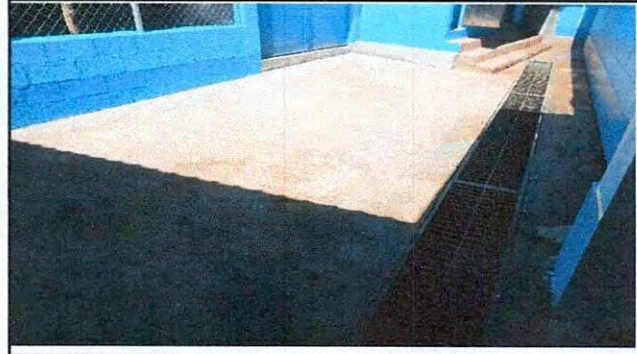
Foto 2: Reparación de piso de concreto
