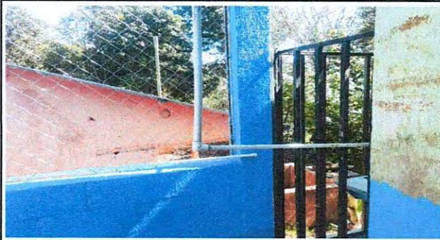
Foto 9: Sustrucción de tubería PVC línea principal
