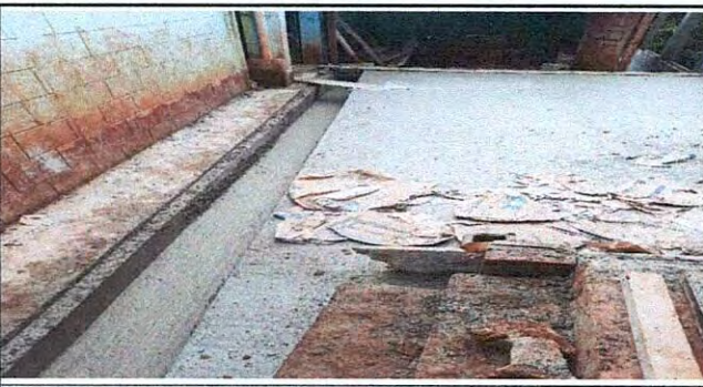
Foto 5: Reparación de cuneta de concreto
