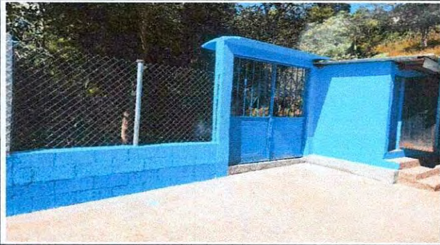
Foto 1: Sustitución de portón de metal
