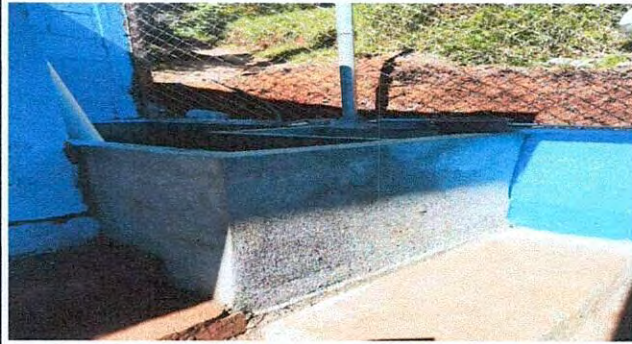
Foto13: Sustitución de pila de cemento de un lavadero.
