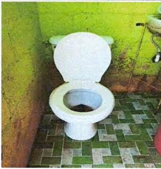
Foto 7: Sustrucción de inodoros
