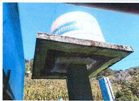
Foto14: Sustitución de depósito de agua de 1,100 lts
