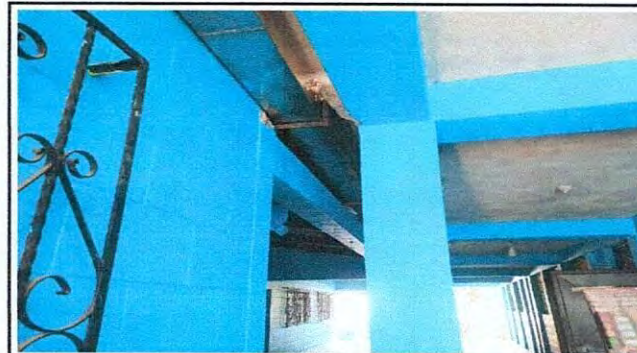
Foto 4: Sustitución de canal de metal
