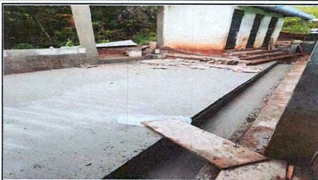
Foto 2: Reparación de piso de concreto
