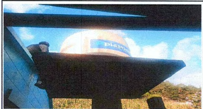
Foto 14: Sustitución de depósito de agua de 1,100 lts
