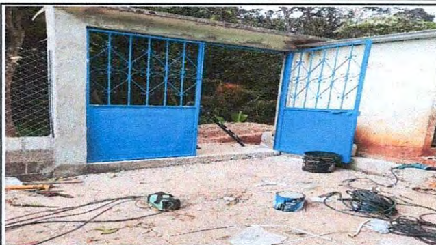
Foto 1: Sustitución de portón de metal
