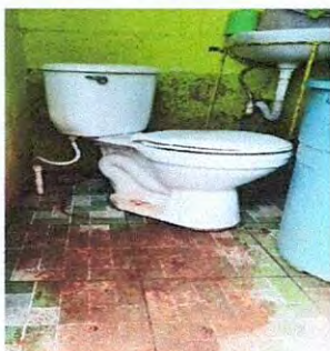
Foto 7: Sustitución de inodoros
