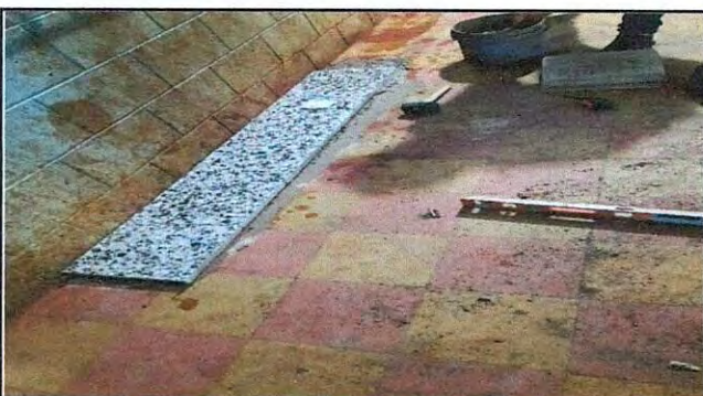
Foto 3: Sustitución de piso de granito
