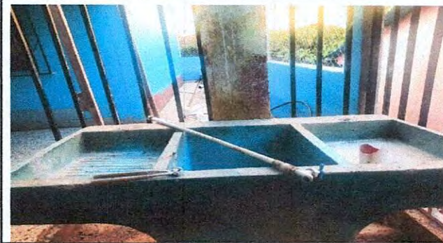
Foto 10: Sustitución de llave de chorro
