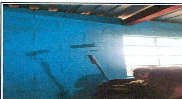
Foto 6: Pintura en muros exteriores e interiores
