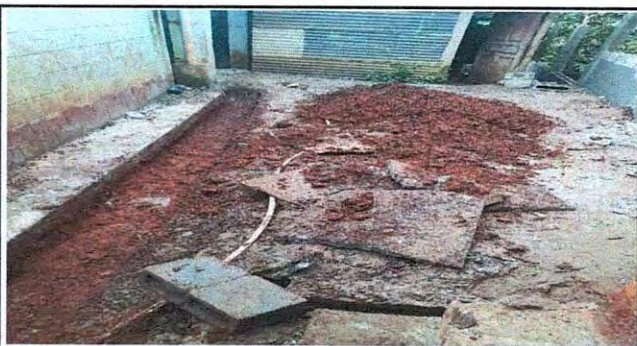
Foto 5: Reparación de cuneta de concreto
