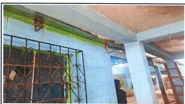
Foto 4: Sustitución de canal de metal
