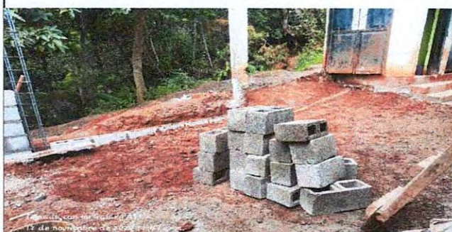
Foto 11: Reparación de muro perimetral con tubo ng y malla galvanizada, soleras intermedias y columnas
