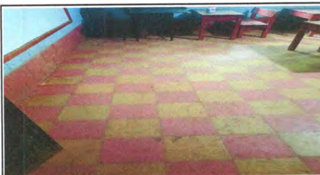
Foto 3: Sustrucción de piso de granito por piso de granito
