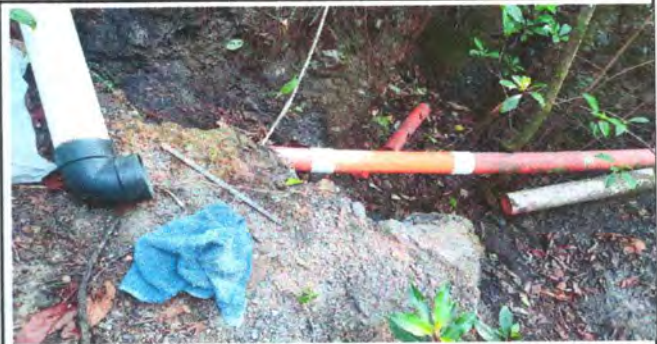
Foto 8: Sustrución de tubería PVC línea principal aguas negras
