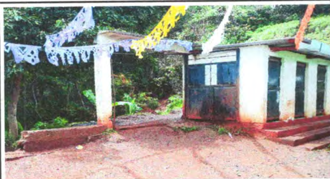
Foto1: Sustrucción de portón de metal por portón de metal
