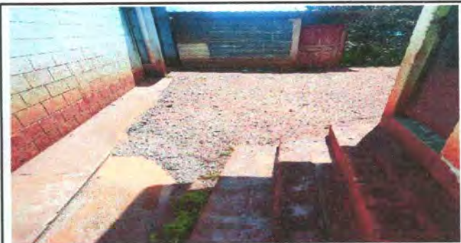
Foto 12: Mejoramiento de Parrilla para protección de cuneta
