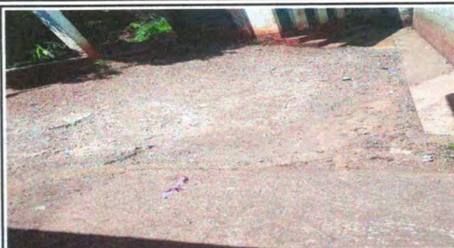
Foto 2: Reparación de piso de concreto
