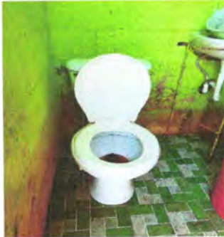
Foto 7: Sustrución de inodoros
