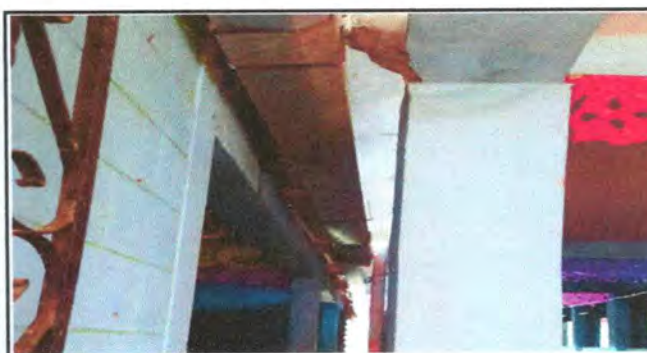
Foto 4: Sustrucción de canal de metal
