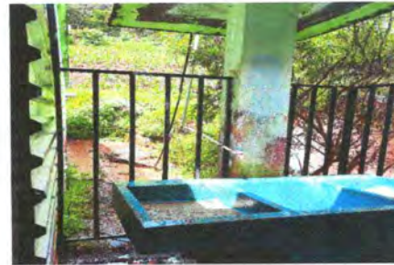
Foto 10: Sustrución de llave de chorro
