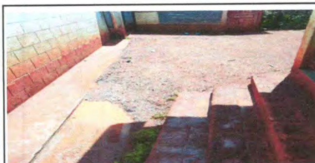
Foto 5: Reparación de cuneta de concreto
