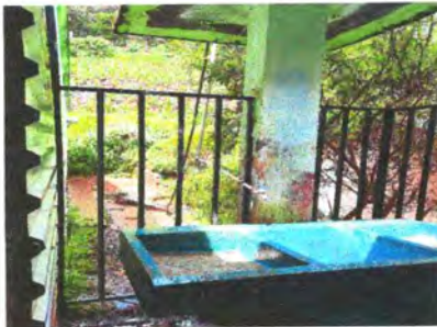
Foto 9: Sustrución de tubería PVC línea principal
