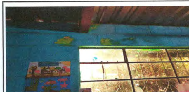
Foto 6: Pintura en muros exteriores e interiores
