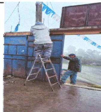
Foto 4: Sustitución de portón de metal
