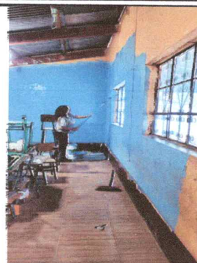
Foto 8: Pintura de muros exteriores e interiores
