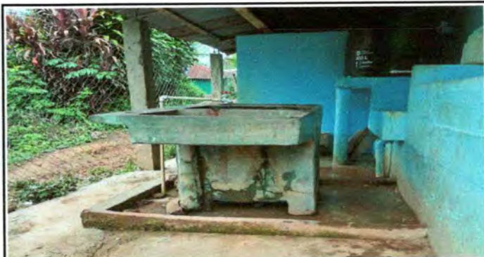
Foto 10: Sustrución de pila de cemento de dos lavaderos
