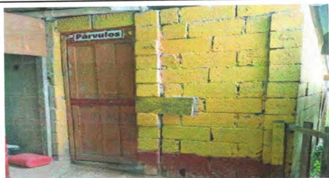
Foto 3: Sustitución de puerta de metal de aula
