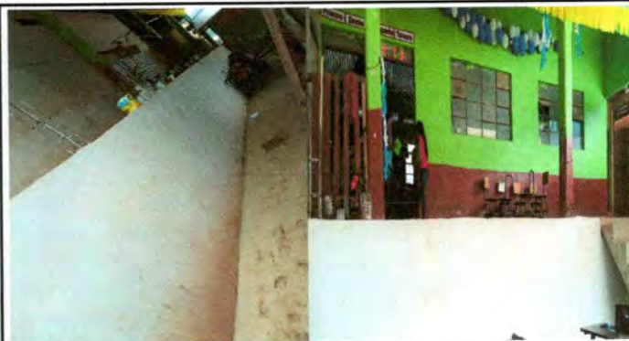
Foto 8: Mejoramiento de baranda de metal
