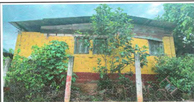
Foto 6: Mejoramiento de balcones de metal
