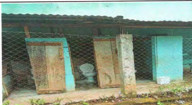
Foto 4: Sustitución de puerta de metal de baños
