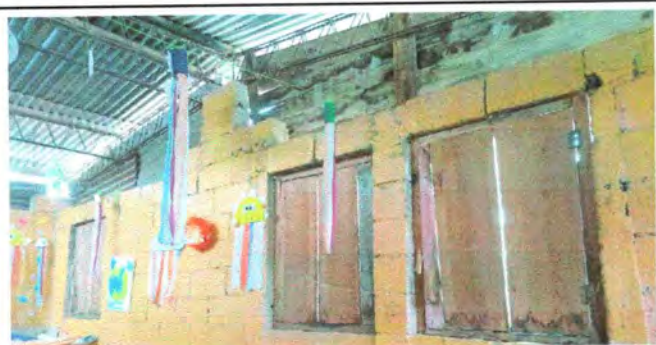
Foto 5: Sustitución de estructura de metal de ventana
