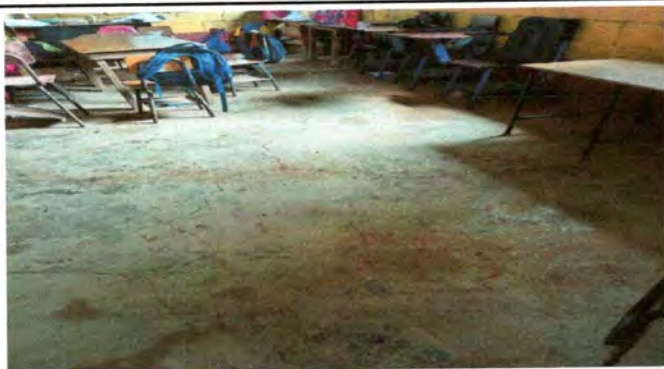
Foto 7: Sustrución de piso de torta de cemento por piso granito
