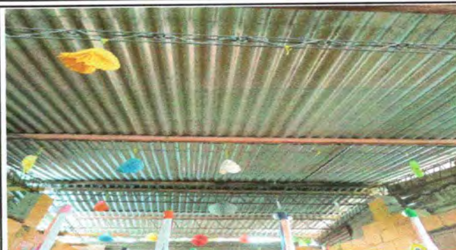
Foto 2: Sustitución de soporte de metal por metal
