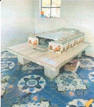
Foto 7: REPARACION DE COCINA
