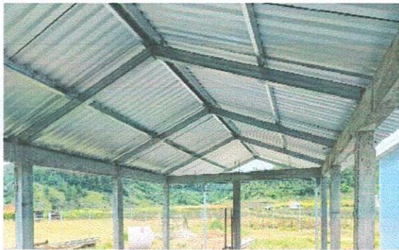
Foto 9: ESTRUCTURA DE SOPORTE DE TECHO
