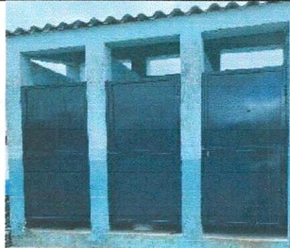
Foto 2: PUERTAS DE METAL
