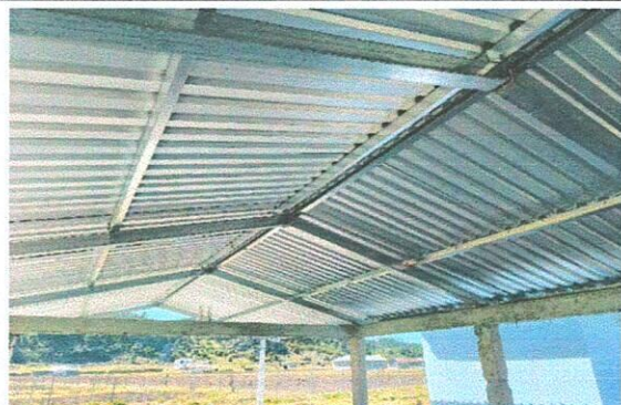
Foto1: CUBIERTA DE LAMINA
