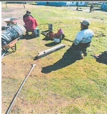
Foto 7: REPARACION DE COCINA
