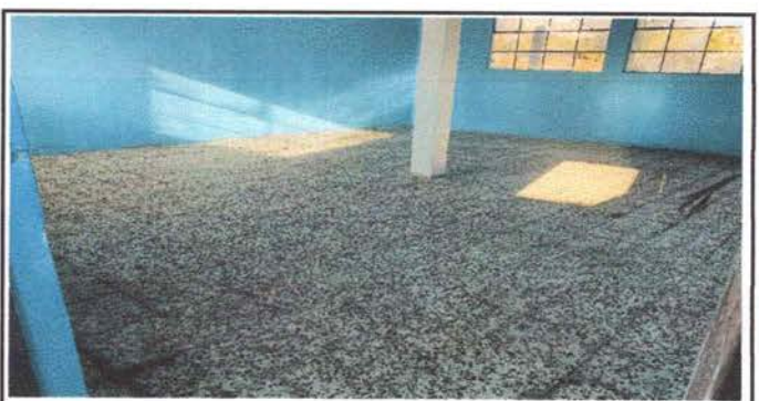
Foto 6: Sustitución de torta de cemento por piso granito
