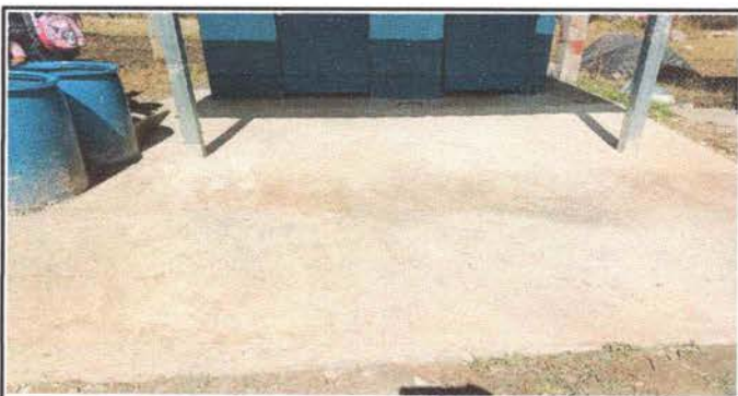
Foto 5: Reparacion de piso de torta de concreto
