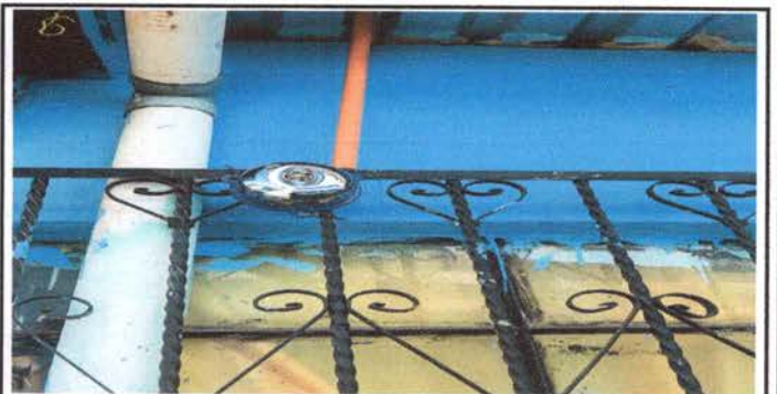
Foto 6: Sustitución de timbre de campana
