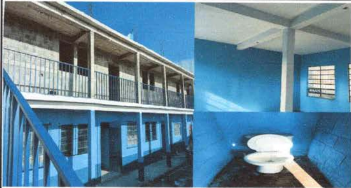
Foto1: Pintura de muros exteriores e interiores
