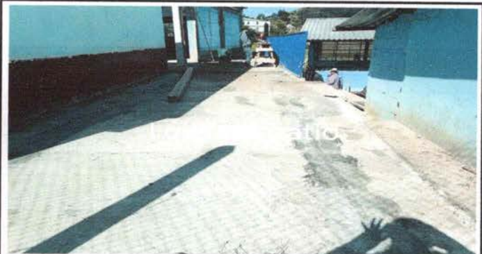
Foto 2: Reparacion de planchas de concreto de patio
