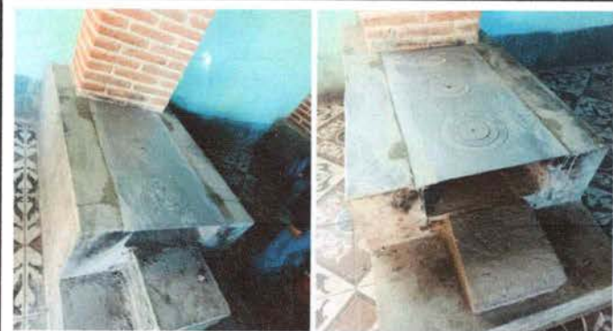
Foto 3: Sustitución de planchas de metal de 3 hornillas por planchas de metal de 3 hornillas
