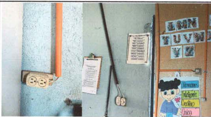
Foto 3: Sustitución de interruptores simples y dobles
