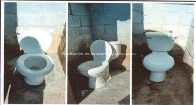
Foto 2: Sustitución de inodoros
