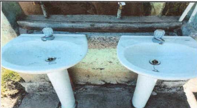
Foto 3: Sustitución de lavamanos de concreto por lavamanos de porcelana
