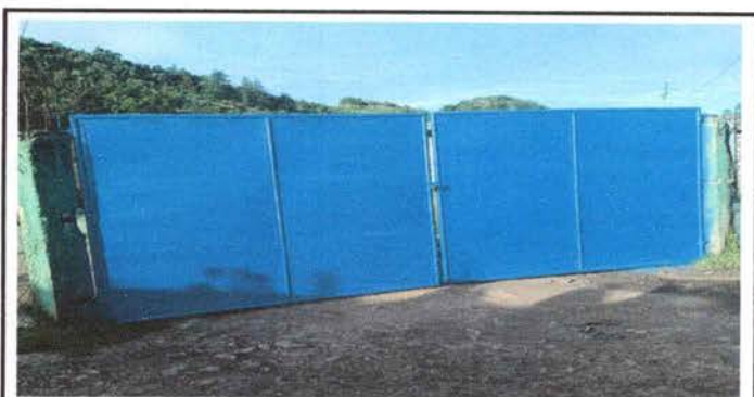
Foto 6: Mantenimiento de porton de metal
