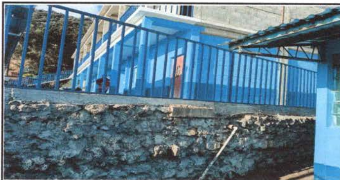
Foto 5: Aplicación de sabieta de muro de contencion
