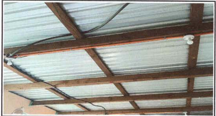
Foto 2: Sustitución de plafoneras
