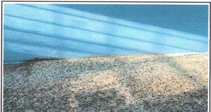
Foto 4: Reparacion de piso granito
