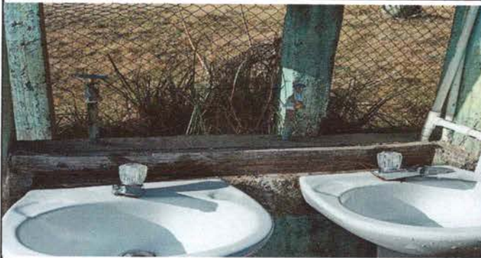
Foto1: Sustitución de llaves de chorro
