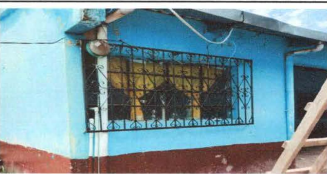
Foto 6: Sustitución de timbre de campana
