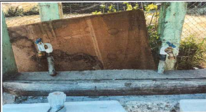
Foto1: Sustrucción de llaves de chorro
