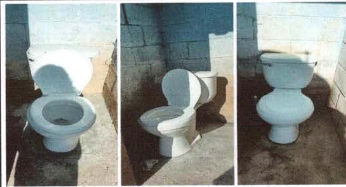
Foto 2: Sustitución de inodoros
