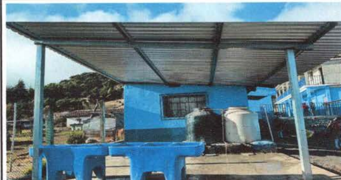
Foto 4: Sustrucción de pilas de cemento de 2 lavaderos por pilas de plastico de 2 lavaderos
