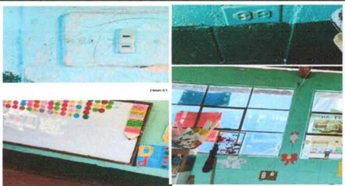
Foto 3: Sustitución de interruptores simples y dobles
