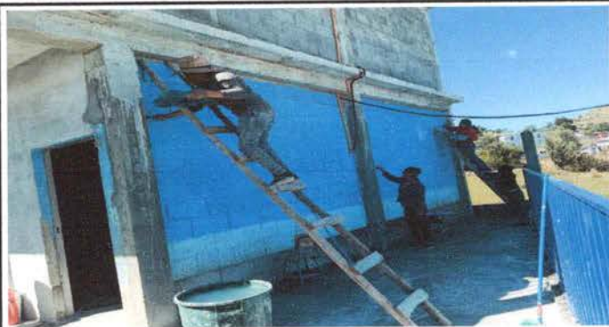
Foto1: Pintura de muros exteriores e interiores
