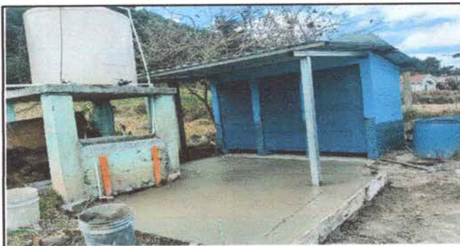
Foto 5: Reparacion de piso de torta de concreto
