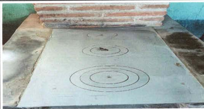
Foto 3: Sustrucción de planchas de metal de 3 hornillas por planchas de metal de 3 hornillas
