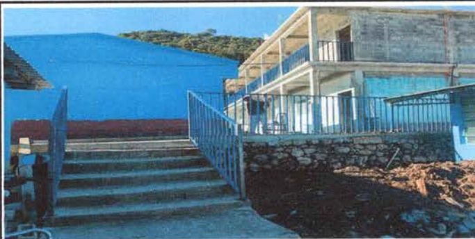
Foto 5: Aplicación de sabieta de muro de contencion
