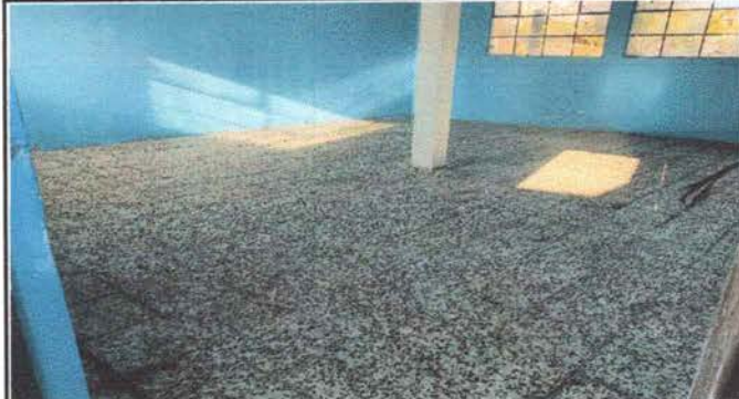
Foto 4: Reparacion de piso granito
