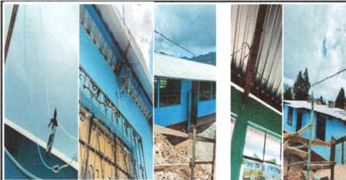
Foto 5: Sustitución de cableado eléctrico/Sustitución de ducto eléctrico mas accesorios
