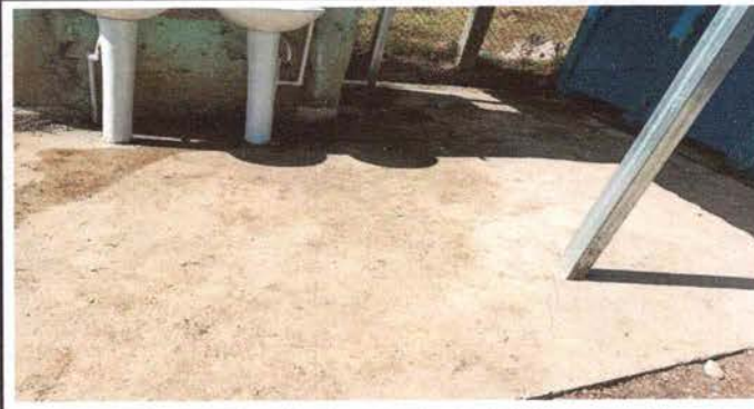
Foto 2: Reparacion de planchas de concreto de patio
