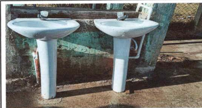
Foto 3: Sustitución de lavamanos de concreto por lavamanos de porcelana
