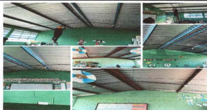
Foto 2: Sustitución de plafoneras
