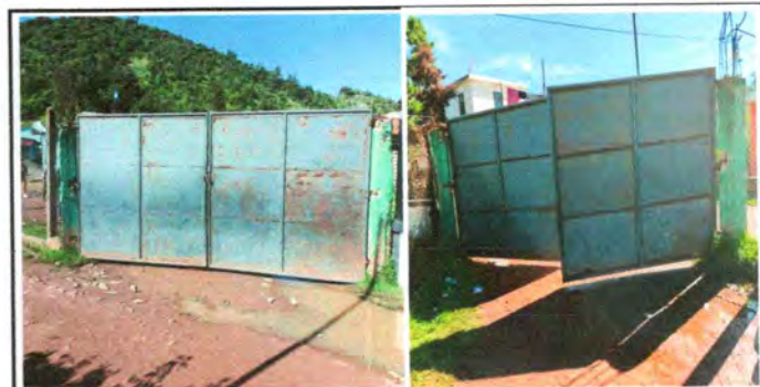
Foto 6: Mantenimiento de porton de metal
