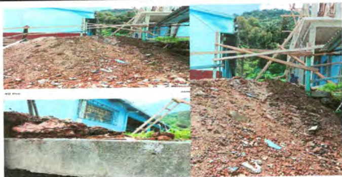
Foto 5: Aplicación de sabieta de muro de contencion
