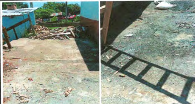
Foto 2: Reparacion de planchas de concreto de patio
