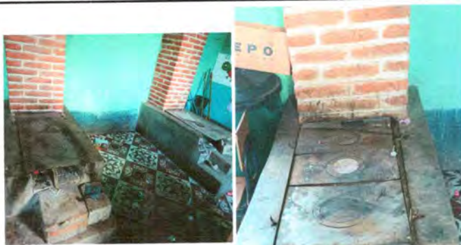
Foto 3: Sustrución de planchas de metal de 3 hornillas por planchas de metal de 3 hornillas
