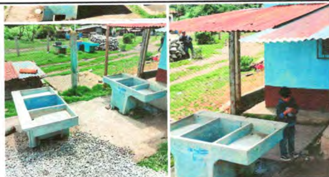
Foto 4: Sustrución de pilas de cemento de 2 lavaderos por pilas de plastico de 2 lavaderos
