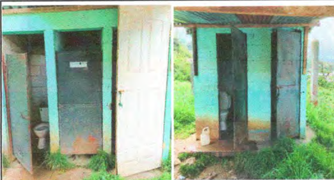
Foto 3: Sustitución de puertas de metal de servicios sanitarios
