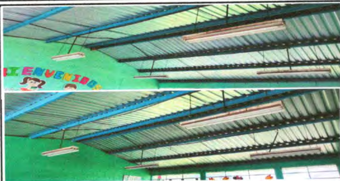
Foto 1: Sustitución de lamparas tipo LED
