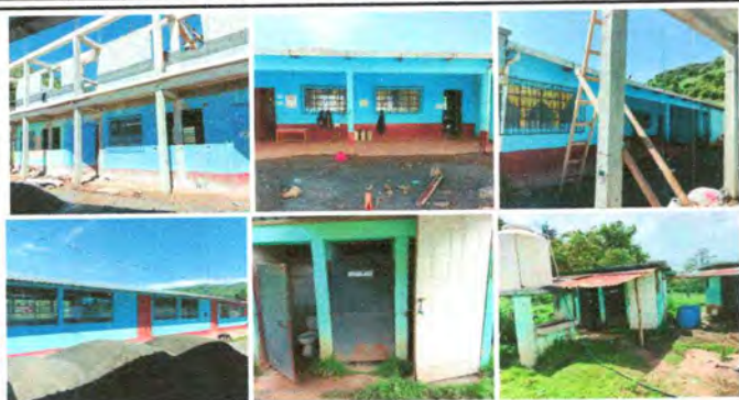
Foto1: Pintura de muros exteriores e interiores
