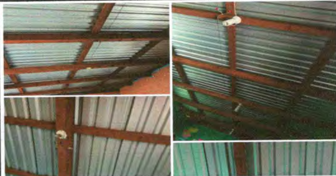
Foto 2: Sustitución de plafoneras
