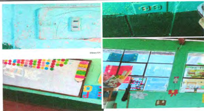
Foto 3: Sustitución de interruptores simples y dobles
