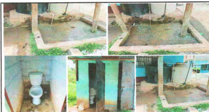
Foto 5: Reparacion de piso de torta de concreto
