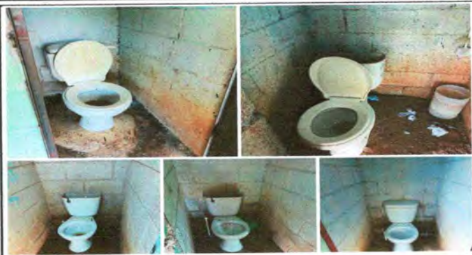
Foto 2: Sustitución de inodoros
