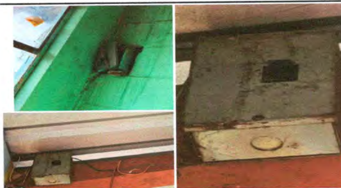
Foto 4: Sustitución de flípones de 1x20/ Sustitución de flípon de 1x40/ Sustitución cajas de flípon tipo BH
