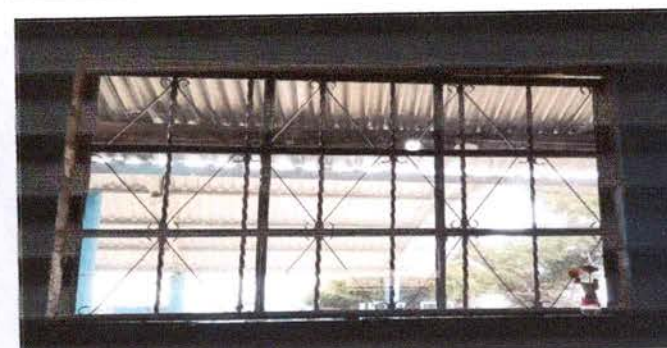
Foto 6: Sustrucción de ventanas de madera a metal
