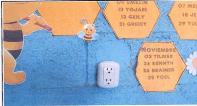
Foto 2: Sustitución tomacorrientes
