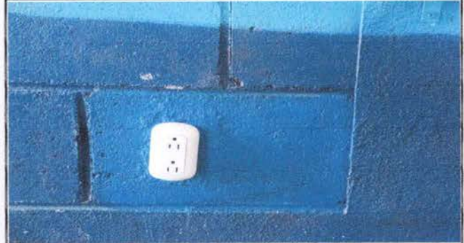
Foto 2: Sustitución de toma corrientes
