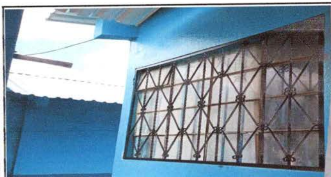
Foto 3: Sustitución de balcon
