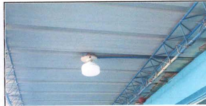
Foto 6: Sustitución de bombilla
