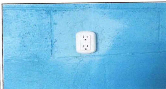
Foto 3: Sustitución de tomacorriente
