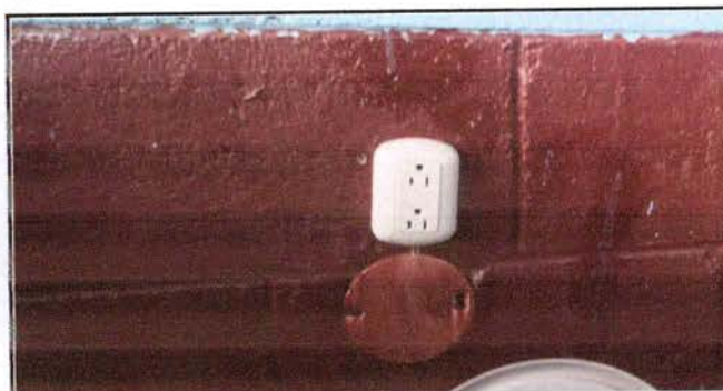
Foto 4: Sustitución del sistema eléctrico
