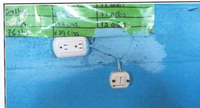
Foto 4: Sustitución de tomacorriente y apagador
