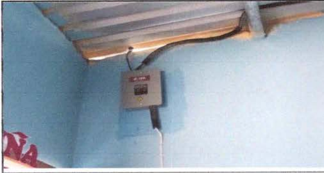
Foto 5: Sustitución de caja eléctrica
