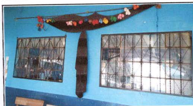
Foto 4: Sustrucción de balcones
