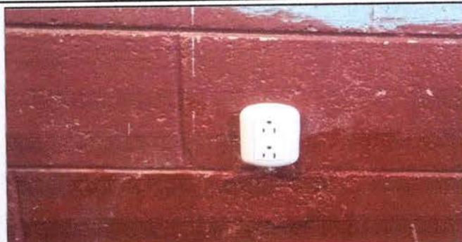
Foto 2: Sustitución de tomacorrientes
