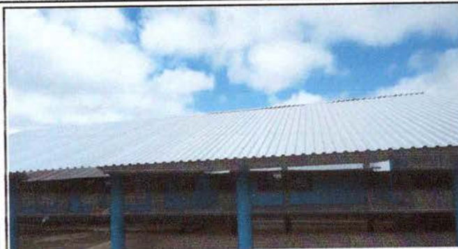
Foto1: RENGLON 1: CUBIERTA DE LAMINA AULA Y SALON
