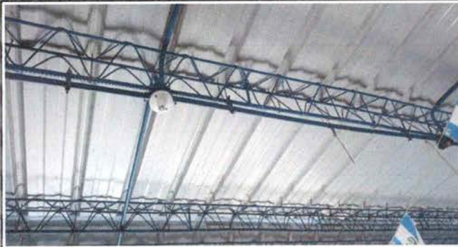
Foto 1: Sustitución de lámpara por plafonera y foco
