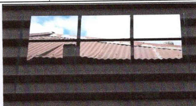
Foto 2: Sustitución de ventana de madera a metal
