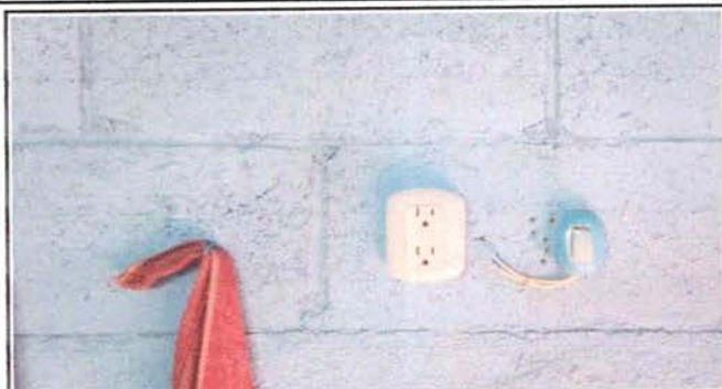
Foto1: RENGLO 5: Sustitución tomacorriente
