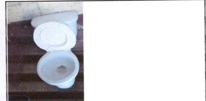
Foto 6: Sustitución de inodoro
