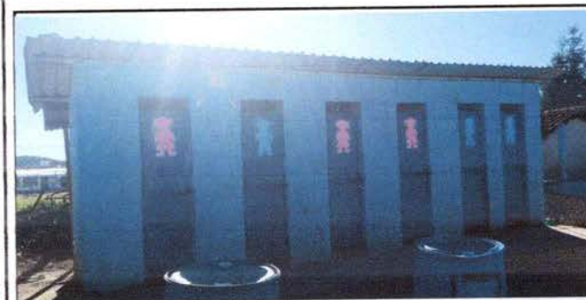
Foto 5: RENGLON 3: Sustitución de inodoros
