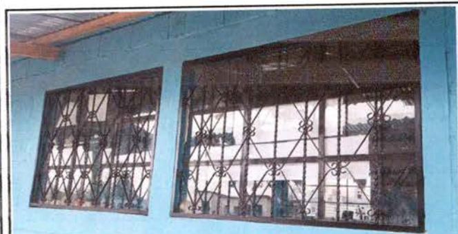
Foto 5: Sustrucción de balcones
