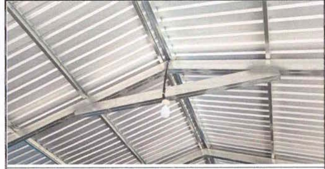
Foto 6: Sustitución de cable y focos
