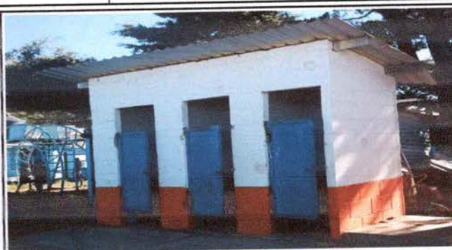
Foto 2: Sustrucción de inodoros
