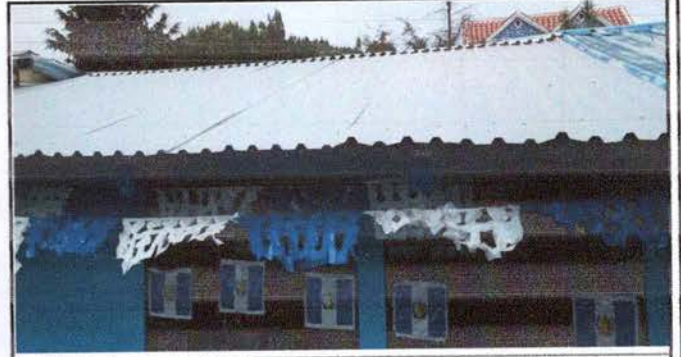
Foto 2: Sustitución de lámina de aula
