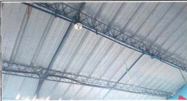
Foto 3: Sustitución de cable
