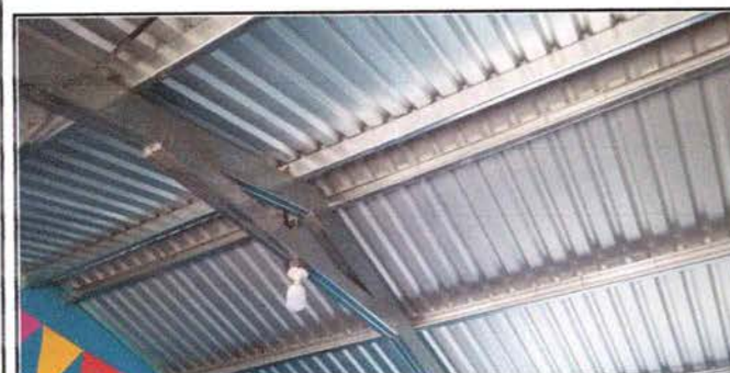
Foto 5: Sustitución sistema electrico
