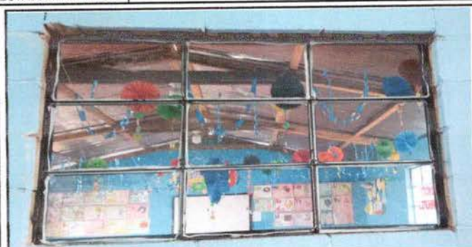
Foto 1: Renglón 4: Sustitución de ventana de madera a metal
