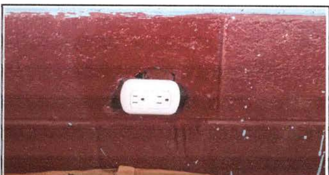
Foto 4: sustitución de toma corrientes
