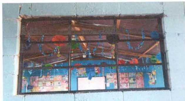
Foto 1: Renglón 4: Sustitución de ventana de madera a metal
