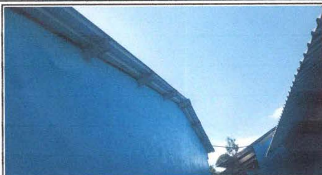
Foto1: RENGLO 5: Reparación de cableado eléctrico
