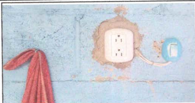
Foto 1: RENGLO 5: Sustitución tomacorriente
