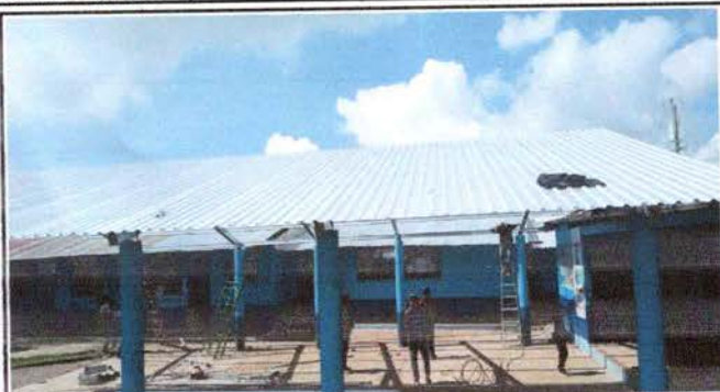
Foto 1: RENGLO 1: CUBIERTA DE LAMINA AULA Y SALON
