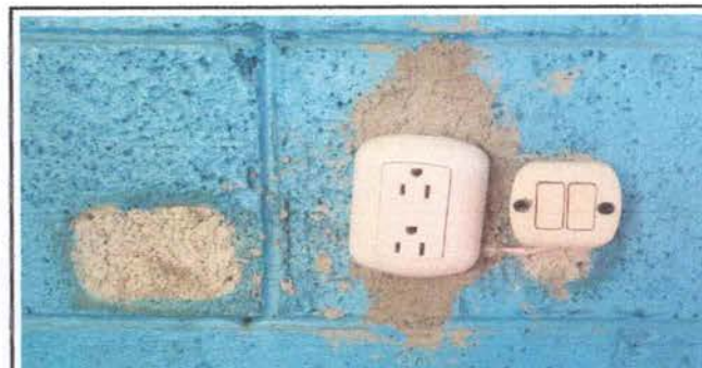
Foto 6: Sustitución de tomacorrientes y apagador
