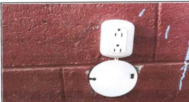
Foto 4: Sustitución del sistema eléctrico
