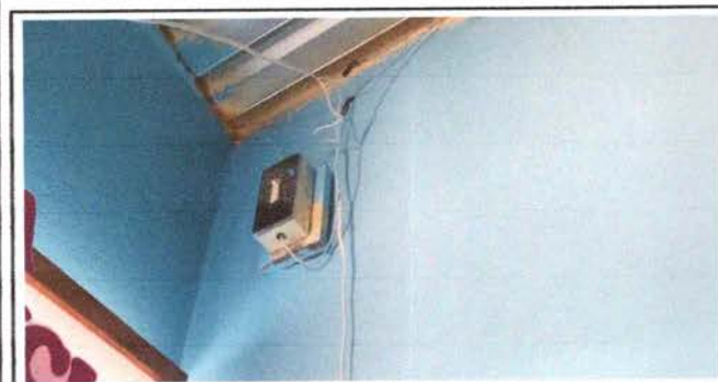
Foto 5: Sustrucción de caja eléctrica
