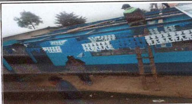
Foto 2: Sustitución de lámina de aula
