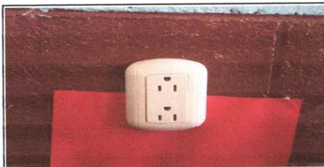
Foto 5: Sustitución tomacorriente
