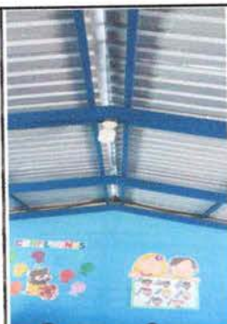
Foto 3: Sustitución de lámina de aula
