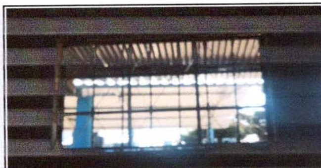
Foto 6: Sustitución de ventanas de madera a metal
