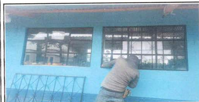
Foto 5: Sustitución de balcones
