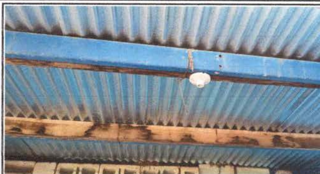
Foto 2: Sustrucción de cable y foco
