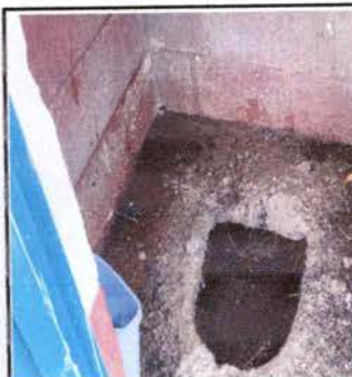
Foto 6: Sustitución de inodoro
