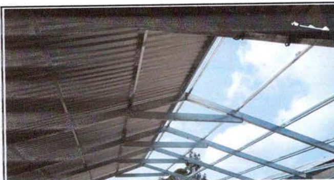
Foto 4: RENGLO 2: ESTRUCTURA DE TECHO
