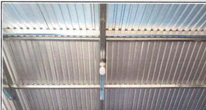
Foto 1: Sustrucción de cable y foco
