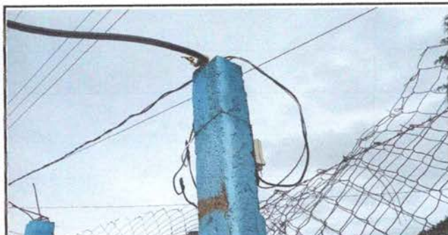
Foto 6: Reparación de cableado eléctrico
