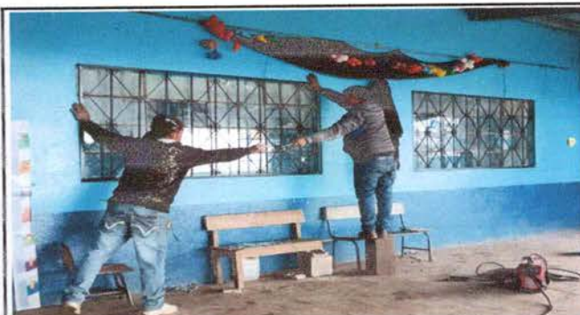
Foto 4: Sustitución de balcones
