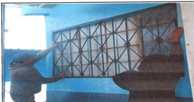
Foto 3: Sustitución de balcón
