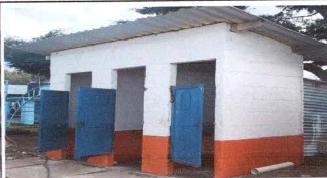
Foto 2: Sustitución de inodoros
