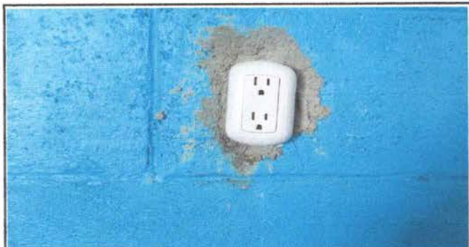
Foto 3: Sustitución de tomacorriente
