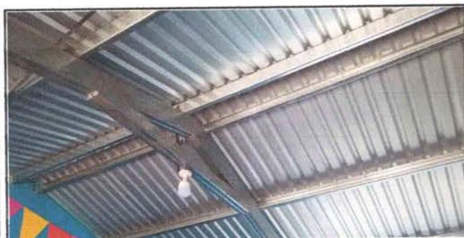
Foto 5: Sustitución sistema electrico
