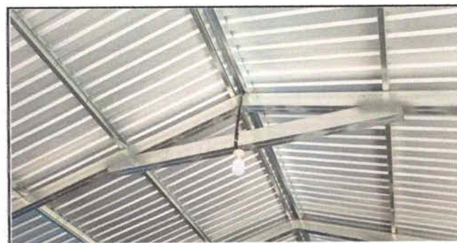
Foto 6: Sustrucción de cable y focos
