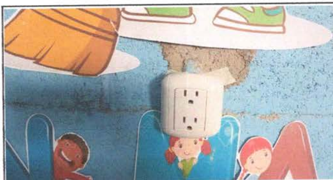
Foto 3: Sustitución tomacorrientes
