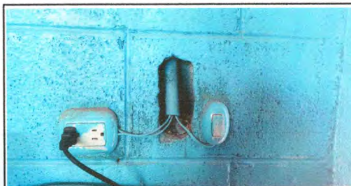
Foto 6: Sustitución de tomacorrientes y apagador
