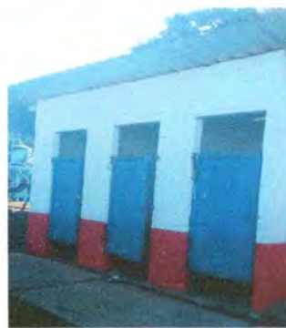
Foto 2: Sustitución de inodoros
