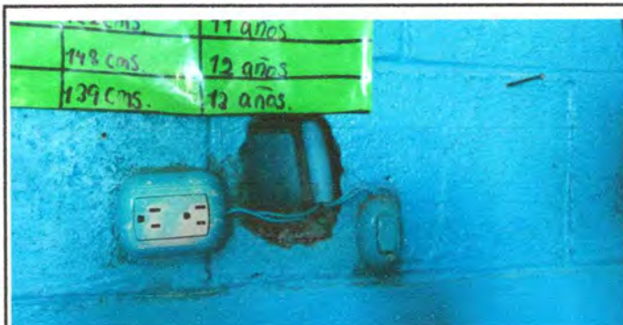
Foto 4: Sustitución de tomacorriente y apagador
