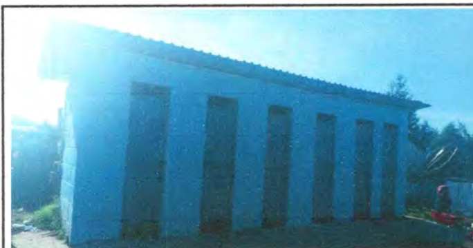
Foto 5: RENGLO 3: Sustitución de inodoros
