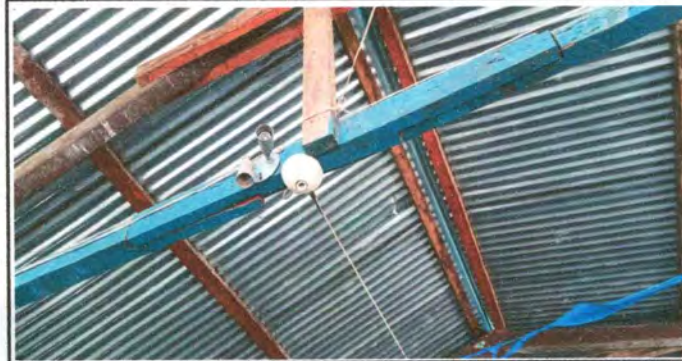
Foto 6: Sustitución de cable y focos
