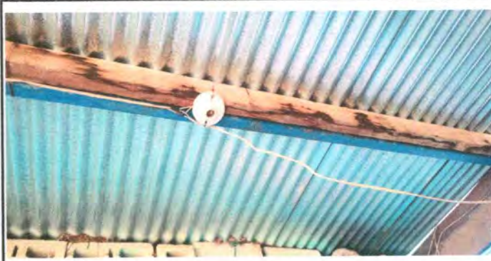
Foto 2: Sustrucción de cable y foco
