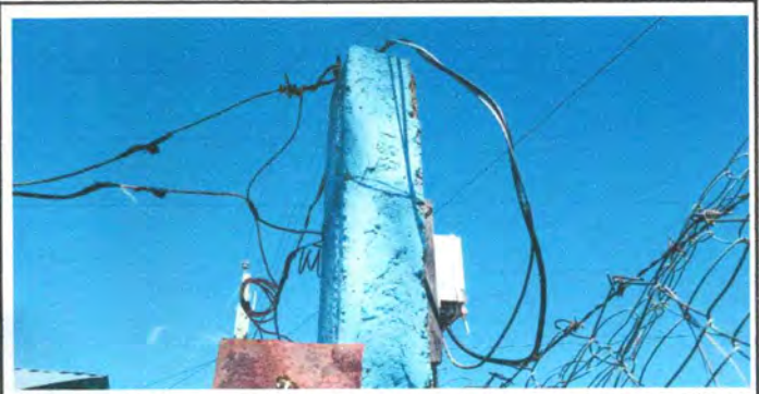
Foto 6: Reparación de cableado eléctrico
