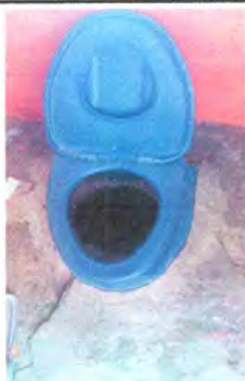
Foto 3: Sustitucion de inodoro
