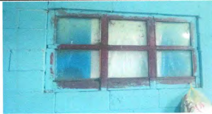
Foto 1: Renglón 4: Sustrucción de ventana de madera a metal
