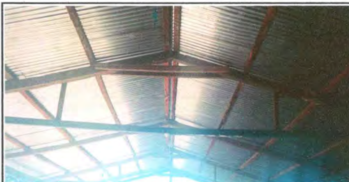
Foto 4: RENGLO 2: ESTRUCTURA DE TECHO
