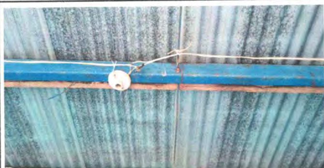
Foto 3: Sustrucción de cable y foco
