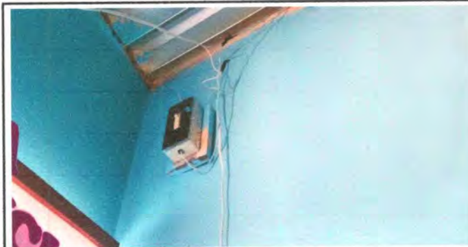
Foto 5: Sustitución de caja eléctrica
