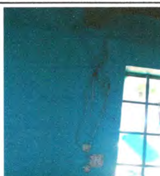
Foto 4: Sustitución sistema electrico
