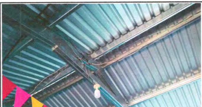
Foto 5: Sustitución sistema electrico
