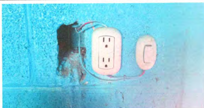
Foto 5: Sustitución de tomacorriente y apagador
