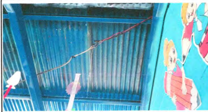
Foto 4: Sustitución de cable
