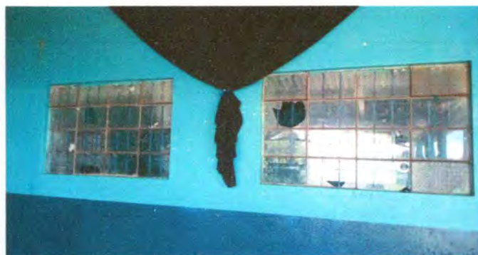
Foto 4: Sustitución de balcones
