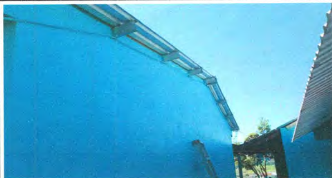
Foto 1: RENGLO 5: Reparación de cableado eléctrico
