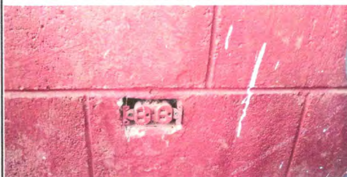
Foto 2: Sustitución de tomacorrientes
