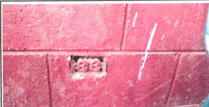
Foto 4: sustitución de toma corrientes
