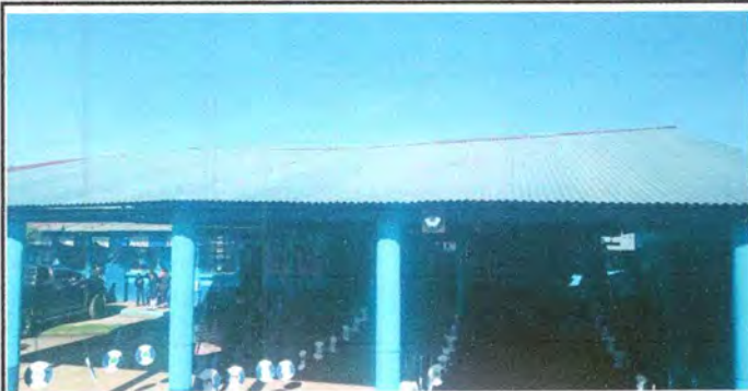
Foto1: RENGLO 1: CUBIERTA DE LAMINA AULA Y SALON
