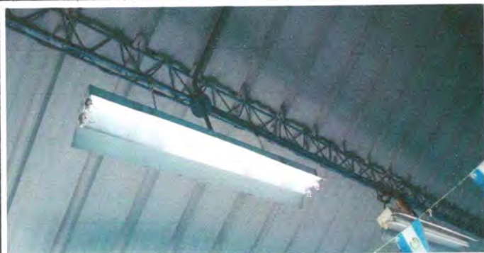
Foto1: Sustitución de lámpara por plafonera y foco
