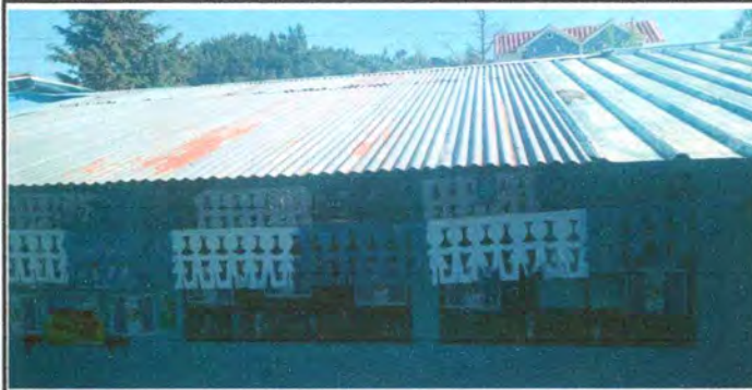
Foto 2: Sustitución de lámina de aula
