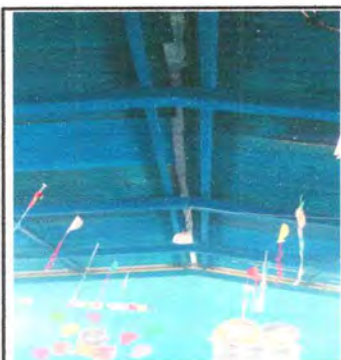
Foto 3: Sustitución de lámina de aula
