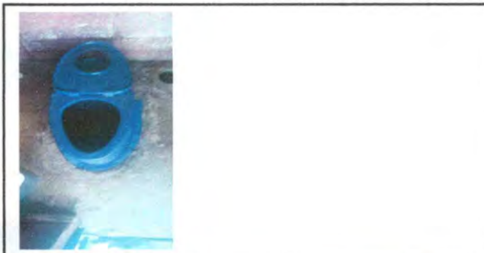
Foto 6: Sustitución de inodoro
