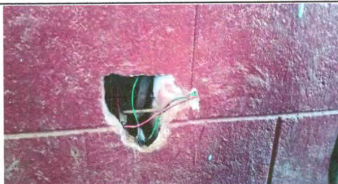
Foto 5: Sustrucción tomacorriente
