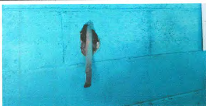
Foto 3: Sustitución de tomacorriente
