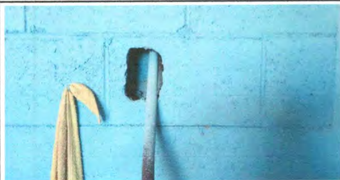
Foto1: RENGLO 5: Sustitución tomacorriente
