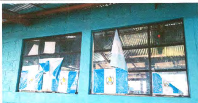
Foto 5: Sustitución de balcones
