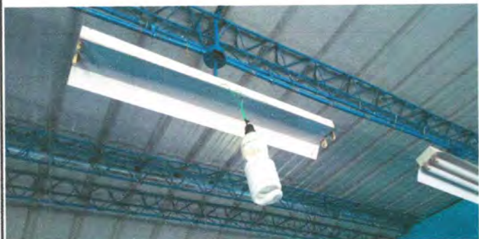
Foto 3: Sustitución de cable
