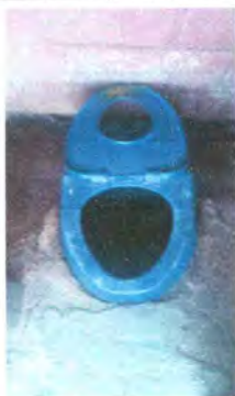
Foto1: Sustitución de inodoro
