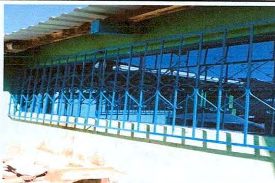
Foto 9: renglon No. 4.4 mantenimiento a balcones de metal
