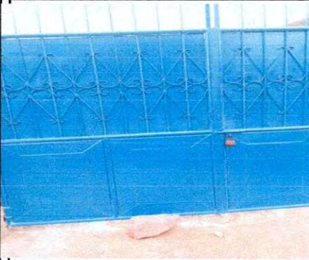
Foto 13: renglon No. 8 reparacion de portones
