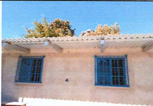
Foto7: renglon No. 4.2 sustitucion de estructura de metal de ventana
