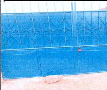
Foto13: renglon No. 8 reparacion de porton, cepillado, fijacion, lijado, aplicacion de pintura
