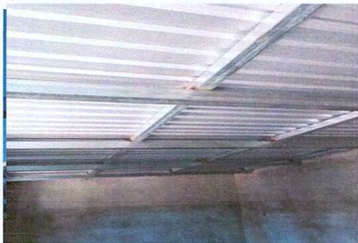
Foto 3. renglón No. 2 sustitucion de soporte de lamina
