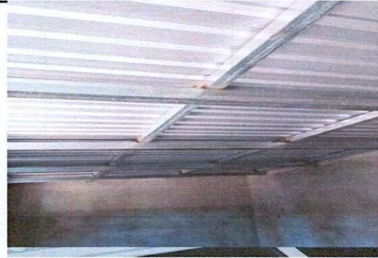
Foto 18: renglon No, 13 mano de obra, instalacion de lamuina troquelada
