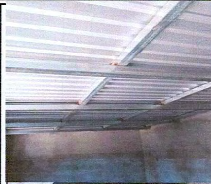
Foto 2. renglón No. 1 cubierta de lamina calibre 26
