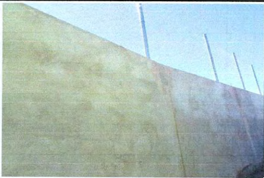
Foto 15: renglon No. 10 reparacion de muros perimetrales
