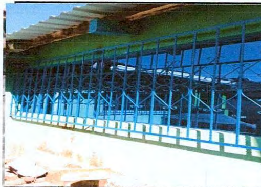
Foto 8: renglon No. 4.3 sustitucion de vidrios
