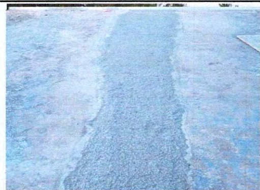
Foto 14: renglon No. 9 sustitucion de tuberiade red de drenaje
