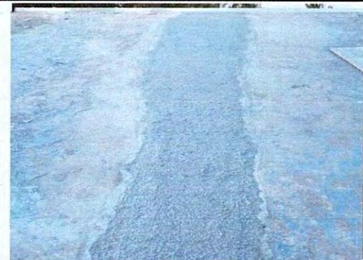
Foto 14: renglon No. 9 reparacion de red de drenaje
