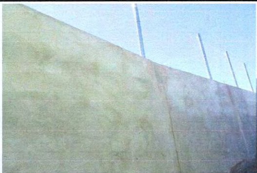
Foto 15: renglon No. 10 reparacion de muros perimetrales
