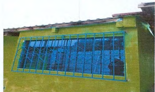
Foto 6: renglon 4.1 mantenimiento de estructura de metal de ventana
