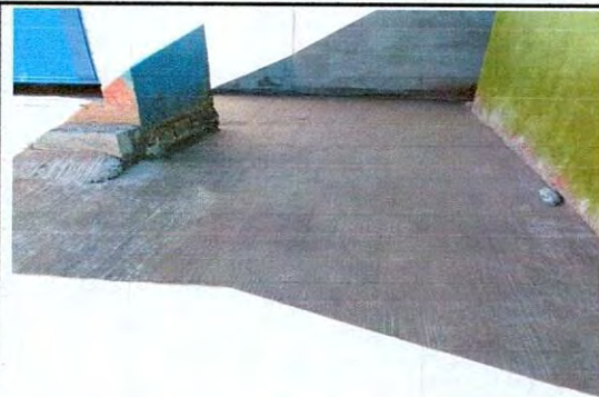
Foto 16: renglon No. 11 losa de patio
