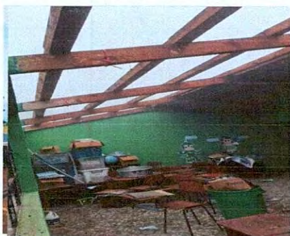
Foto1: renglon No. 1 sustitucion de lamina por lamina troquelada calibre 26
