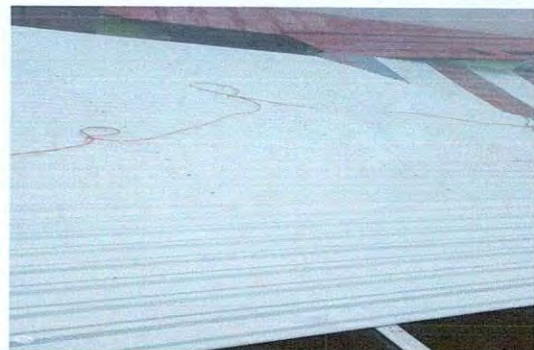
Foto 18: renglon No, 13 mano de obra, instqlacion de lamina troquelada
