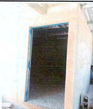
Foto 5. renglon 3.2 sustitucion de puerta de metal
