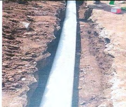
Foto 14: renglon No. 9 sustitucion de tuberia de red de drenaje
