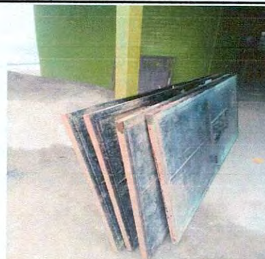
Foto 4: renglón No. 3.1 reparacion de puertas de metal, lijado, cepillado, aplicacion de pintura
