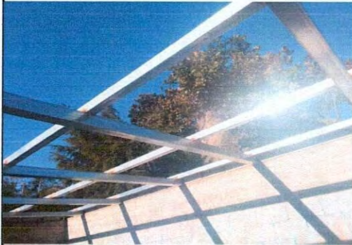
Foto19: renglon No. 13 mano de obra, cambio de lamina troquelada
