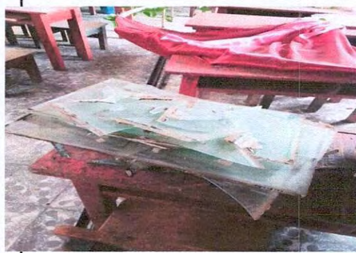
Foto 8: renglon No. 4.3 sustitucion de vidrios
