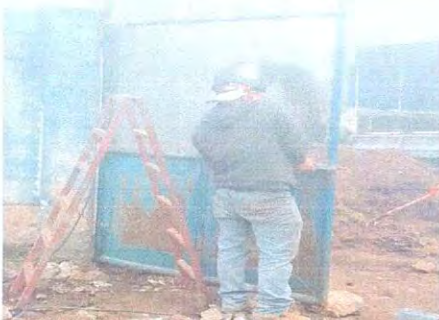
Foto13: renglon No. 8 reparacion de portonen lijado, cepillado, aplicacion de pintura
