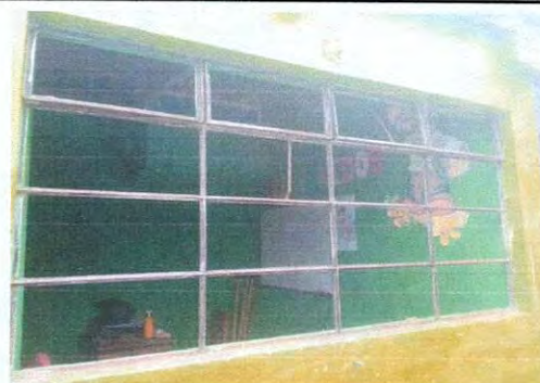
Foto 6: renglon 4.1 manteneimiento de estructura de metal de ventana
