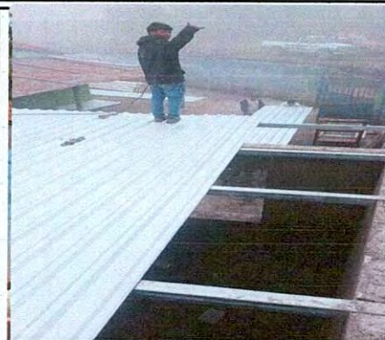
Foto 2. renglón No. 1 cubierta de lamina calibre 26
