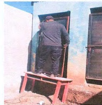
Foto 12: Renglón No. 7 servicios sanitarios, reparacion en puertas de servicios sanitarios cepillado, fijacion, aplicacion de pintura
