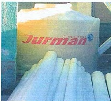
Foto 17: renglon No. 12 colocación deposito de agua de 2500 litros
