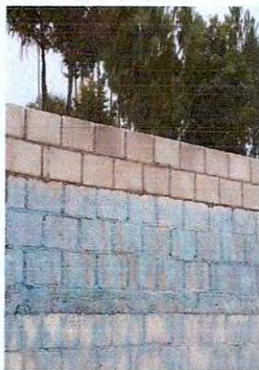
Foto 15: renglon No. 10 reparacion de muros perimetrales
