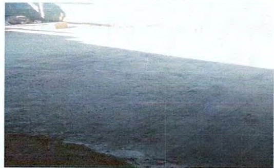
Foto 16: renglon No. 11 losa de patio , aplicacion de torta de cemento
