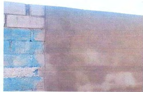
foto 20. renglon 14 repello en muros perimetrales
