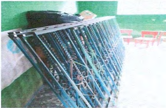
Foto 9: renglon No. 4.4 mantenimiento a balcones de metal
