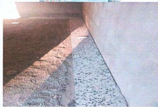
Foto 10: renglon No. 5 mejoramiento de piso de granito
