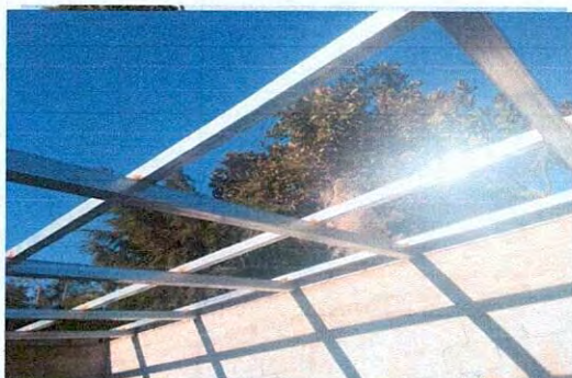
Foto 3. renglón No. 2 sustitucion de soporte de lamina
