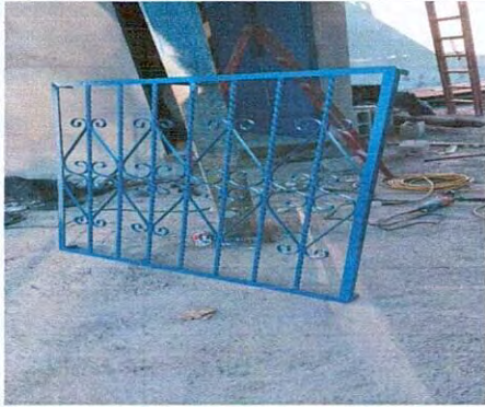
Foto 7: renglon No. 4.2 sustitucion de estructura de metal de ventana
