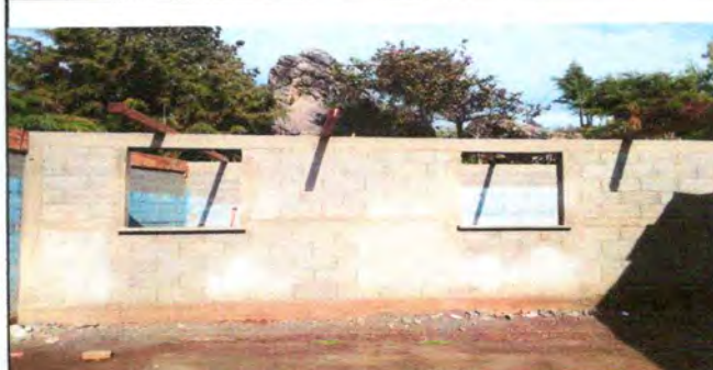
Foto 6: renglon 5 sustitucion a estructura de metal de ventanas
