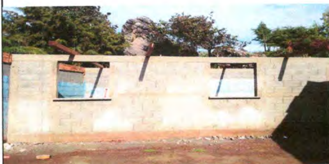
Foto 3: renglón No. 2 estructura de techo
