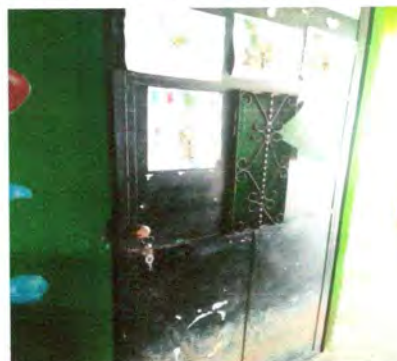
Foto 4: renglón No. 3 reparacion de puertas de metal
