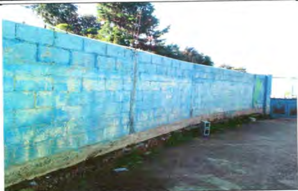
Foto19: renglon No. 14 repello de muros perimetrales,
