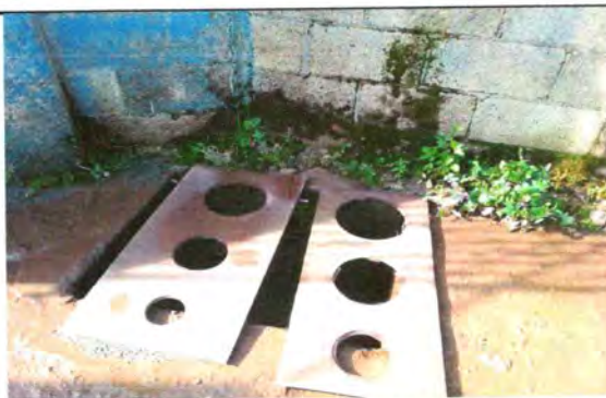
Foto 12: Renglón No. 9 reparacion de red de drenaje
