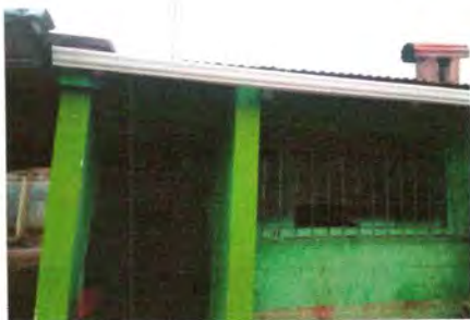
Foto 9: renglon No. 6 canales y bajadas de agua
