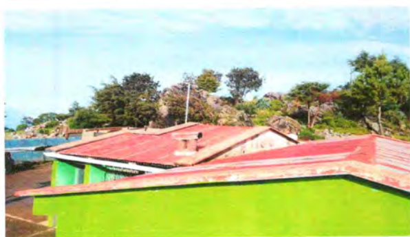
Foto1: renglon No. 1 sustitucion de lamina por lamina
