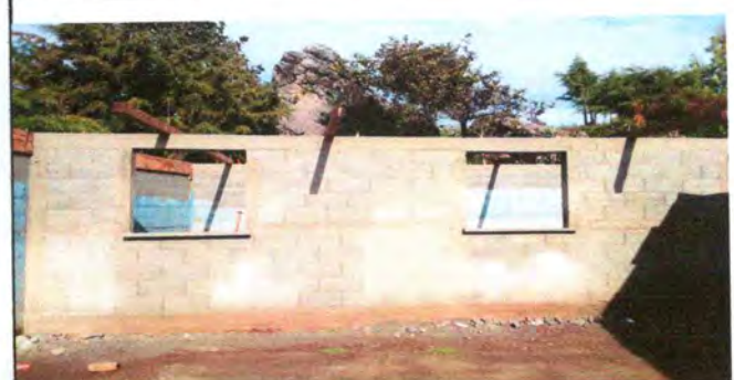
Foto 18: renglon No, 14 repello repello a muros
