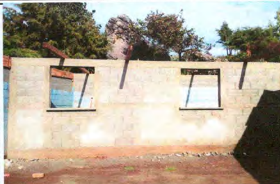
Foto 2: renglón No. 1 cubierta de lamina
