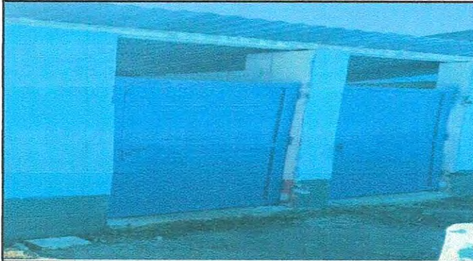
SUSTITUCIÓN DE PUERTA EN SERVICIO SANITARIO
