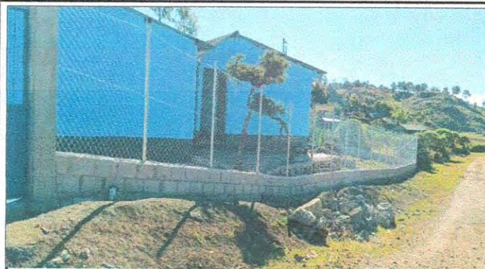
SUSTITUCIÓN DE MUROS PERIMETRALES
