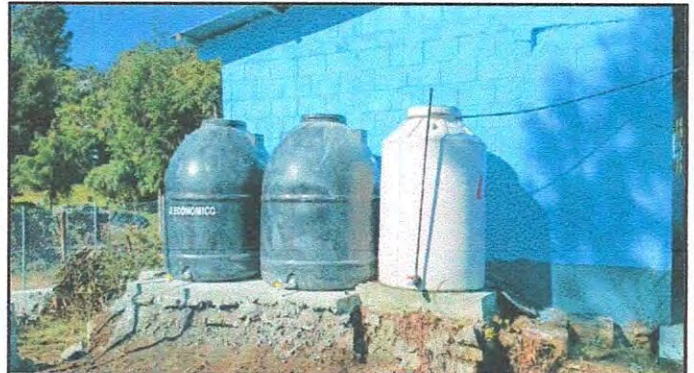
SUSTITUCIÓN DE DEPOSITO DE AGUA
