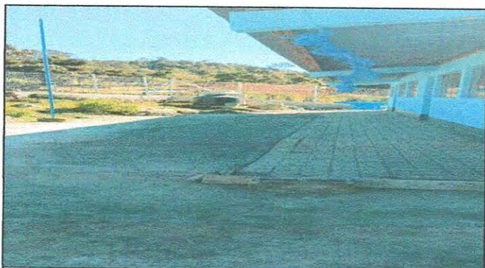
REPARACION DE PLANCHAS DE CONCRETO DE PATIO
