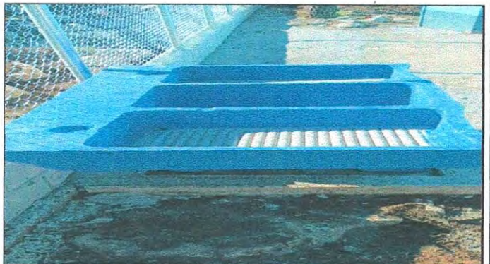
SUSTITUCION DE PILA DE CEMENTO
