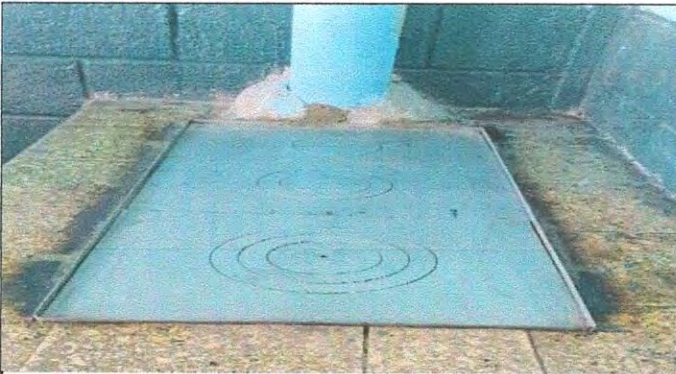
SUSTITUCION DE PLANCHA
