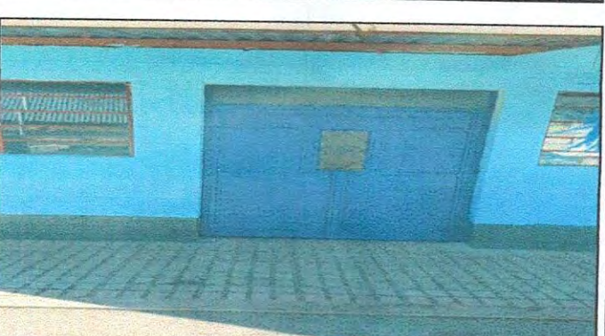
SUSTITUCION DE PUERTAS
