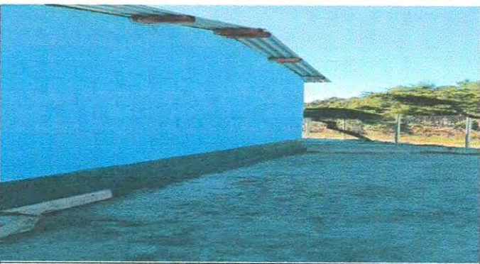
PINTURA DE MUROS DE EXTERIORES E INTERIORES
