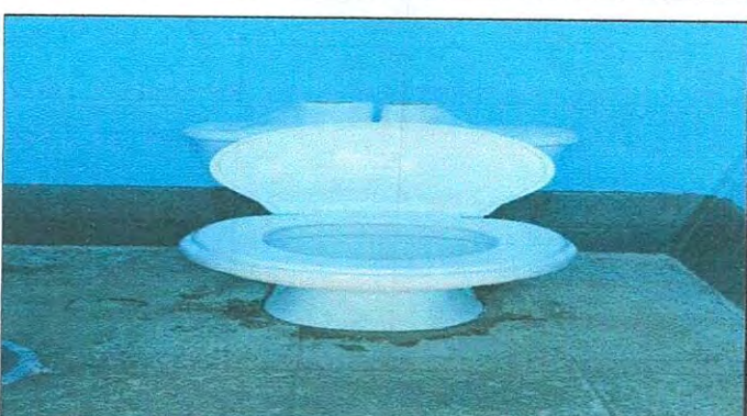
SUSTITUCION DE INODOROS
